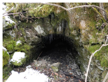
Vestiges de ce qui pourrait être un élément du haut-fourneau. Phot. Clara Bérelle IVR82_20137302788NUCA
