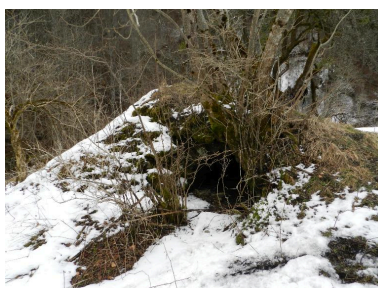
Vestiges de ce qui pourrait être un élément du haut-fourneau. Phot. Clara Bérelle IVR82_20137301902NUCA
