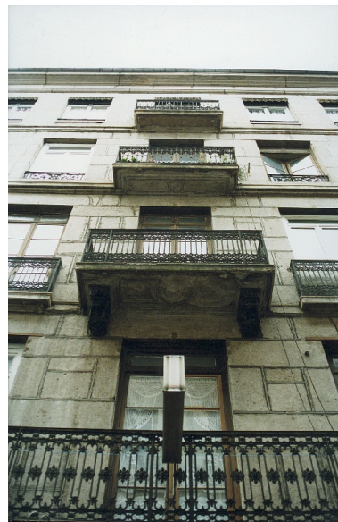
Façade principale. Travée centrale Phot. Cendrine Sanquer IVR82_20084200568NUCA
