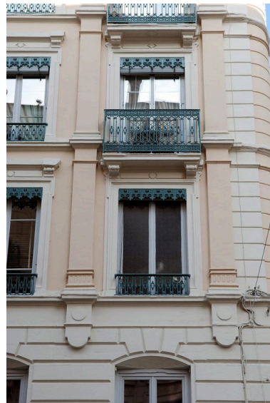
Elévation antérieure : détail Phot. Véronique Belle IVR82_20096903145NUCA
