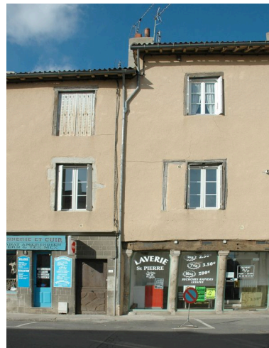
Vue générale de l'élévation donnant sur la place. Phot. Simone Hartmann-Nussbaum IVR82_20114200611NUCA
