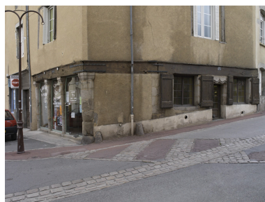
Vue de trois-quarts du rez-de-chaussée soutenu par une poutre sablière. Phot. Eric Dessert IVR82_20084200618NUCA
