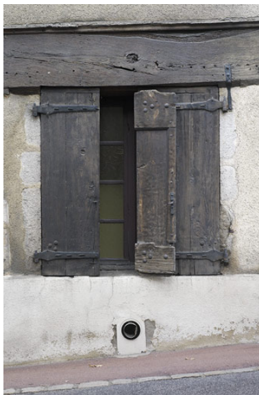
Rez-de-chaussée : la poutre sablière sert de linteau de fenêtre. Phot. Didier Gourbin IVR82_20074201285NUCA
