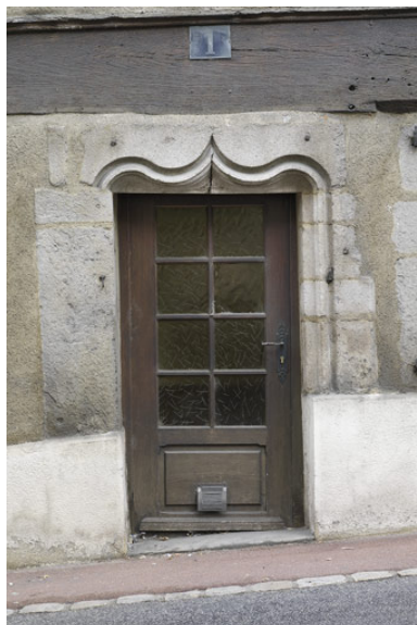
Porte piétonne avec linteau en accolade, 1 rue Saint-Pierre. Phot. Didier Gourbin IVR82_20074201284NUCA
