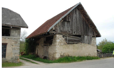
Vue d'ensemble. Phot. Caroline Guibaud IVR82_20157303018NUCA
