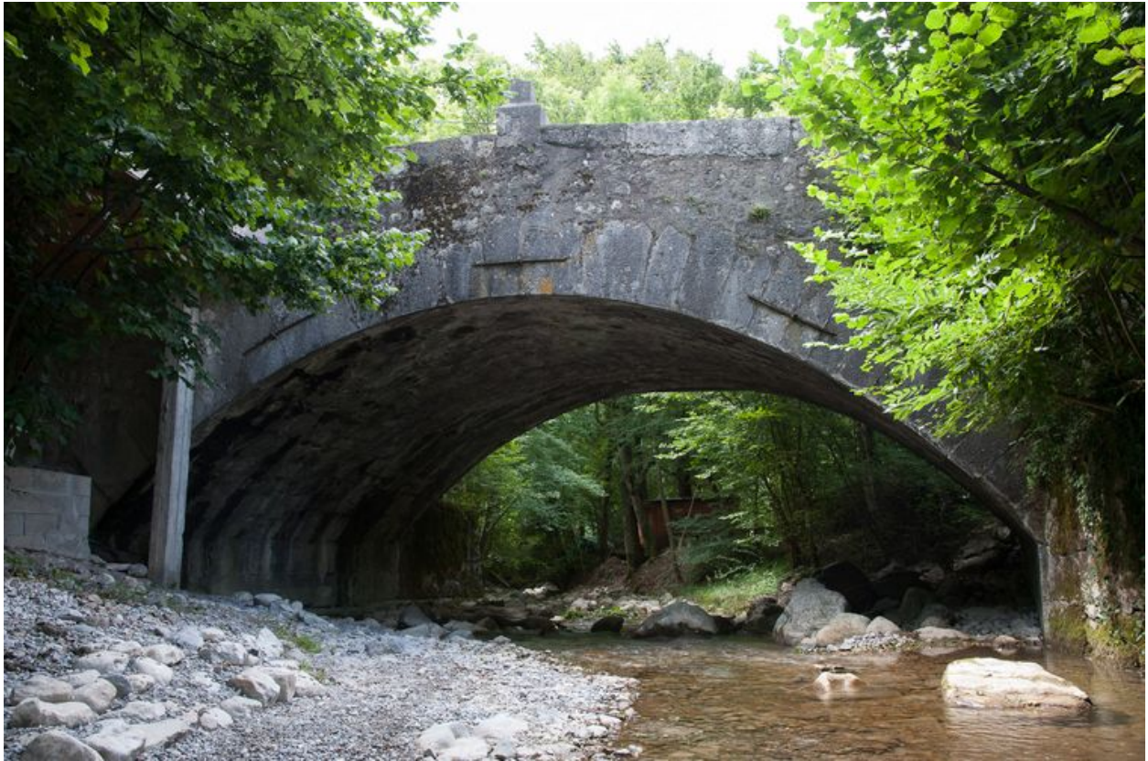
Vue générale depuis le cours d'eau.
