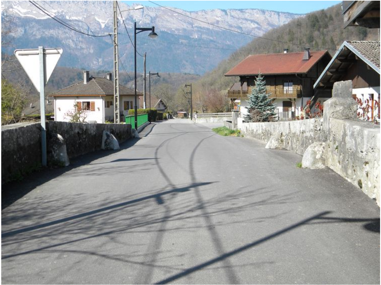
Vue de la chaussée du pont.
