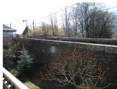
Vue du mur de soutènement de la rampe en rive droite. Phot. Jérôme Daviet IVR82_20127400875NUCA
