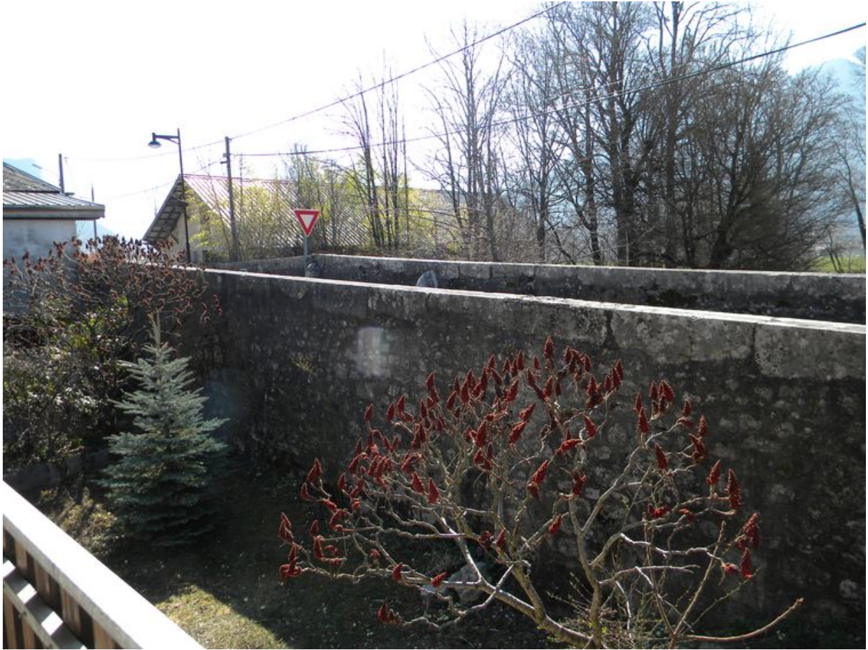
Vue du mur de soutènement de la rampe en rive droite.
