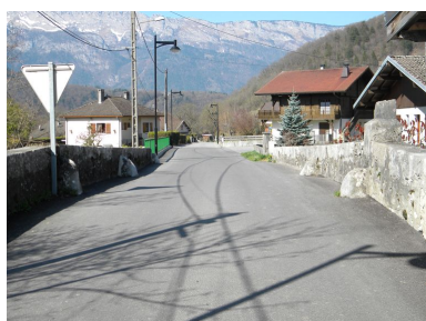
Vue de la chaussée du pont. Phot. Jérôme Daviet IVR82_20127400876NUCA
