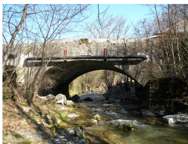
Vue du pont depuis l'aval. Phot. Jérôme Daviet IVR82_20127400874NUCA
