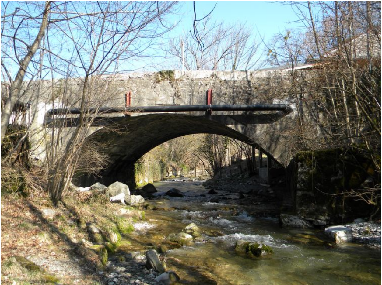
Vue du pont depuis l'aval.
