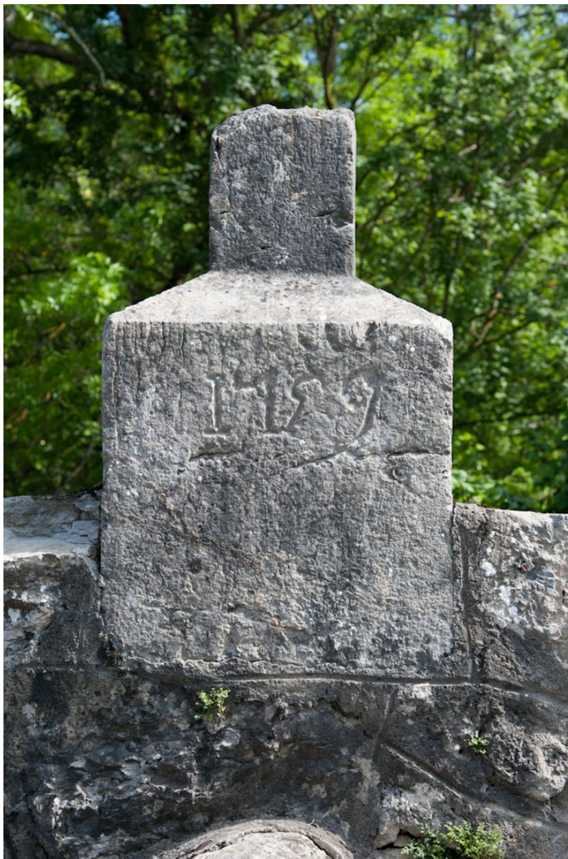
Socle d'une ancienne croix sur le parapet portant la date 1759.
