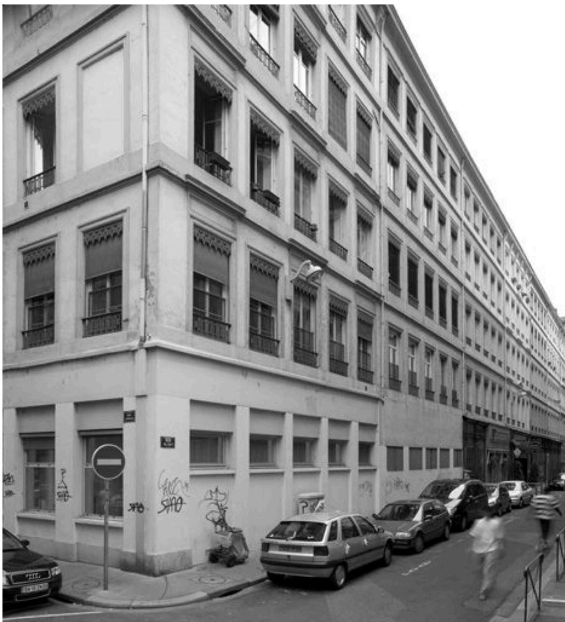
Vue générale des élévations sur la rue Pléney
