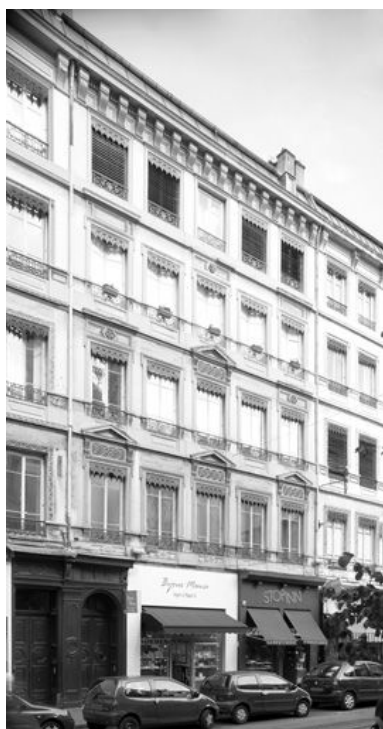
Détail de la façade axiale rue Paul-Chenavard Phot. Didier Gourbin IVR82_20056901554NUC
