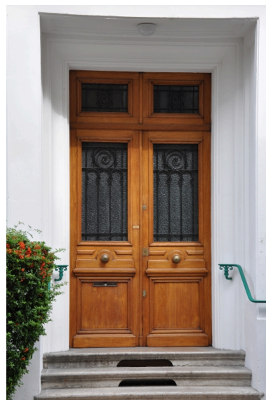
Porte d'entrée Phot. François Fouger IVR82_20117300583NUCA
