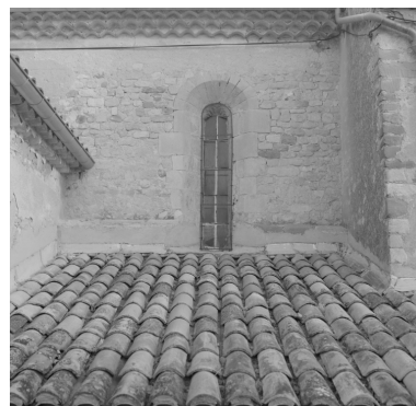
Elévation sud, détail : fenêtre à tympan sculpté en coquille sous un arc plein cintre. Phot. Alain Franchella IVR82_19992600037X
