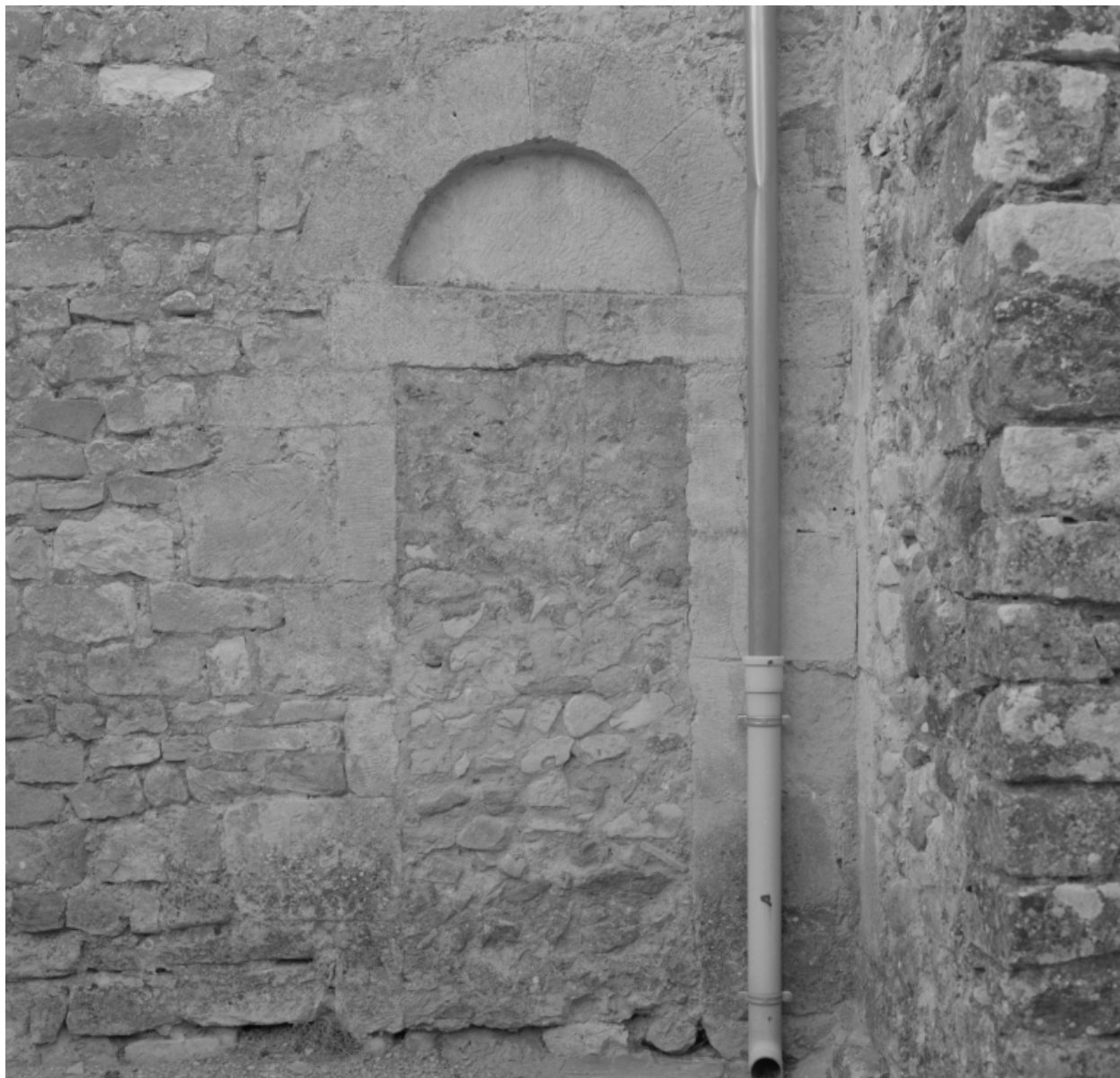
Elévation nord, détail : porte murée, entrée de l'ancien prieuré (?)
