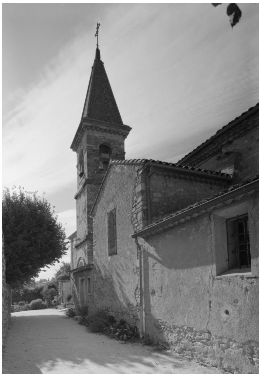
Elévation sud, vue partielle.
