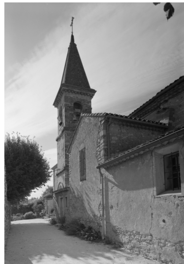
Elévation sud, vue partielle. Phot. Jean-Marie Refflé IVR82_20002600835P
