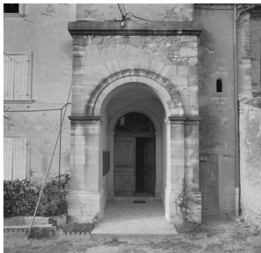
Clocher-porche, entrée de l'édifice. Phot. Alain Franchella IVR82_19992600035X
