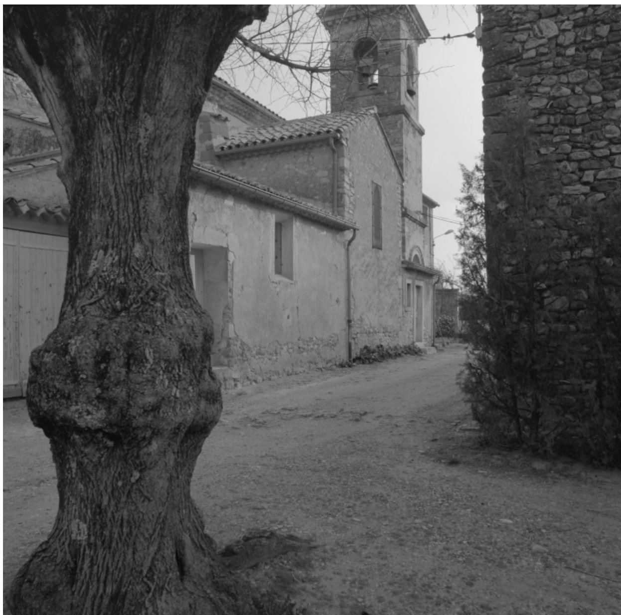
Vue partielle depuis le sud-est.
