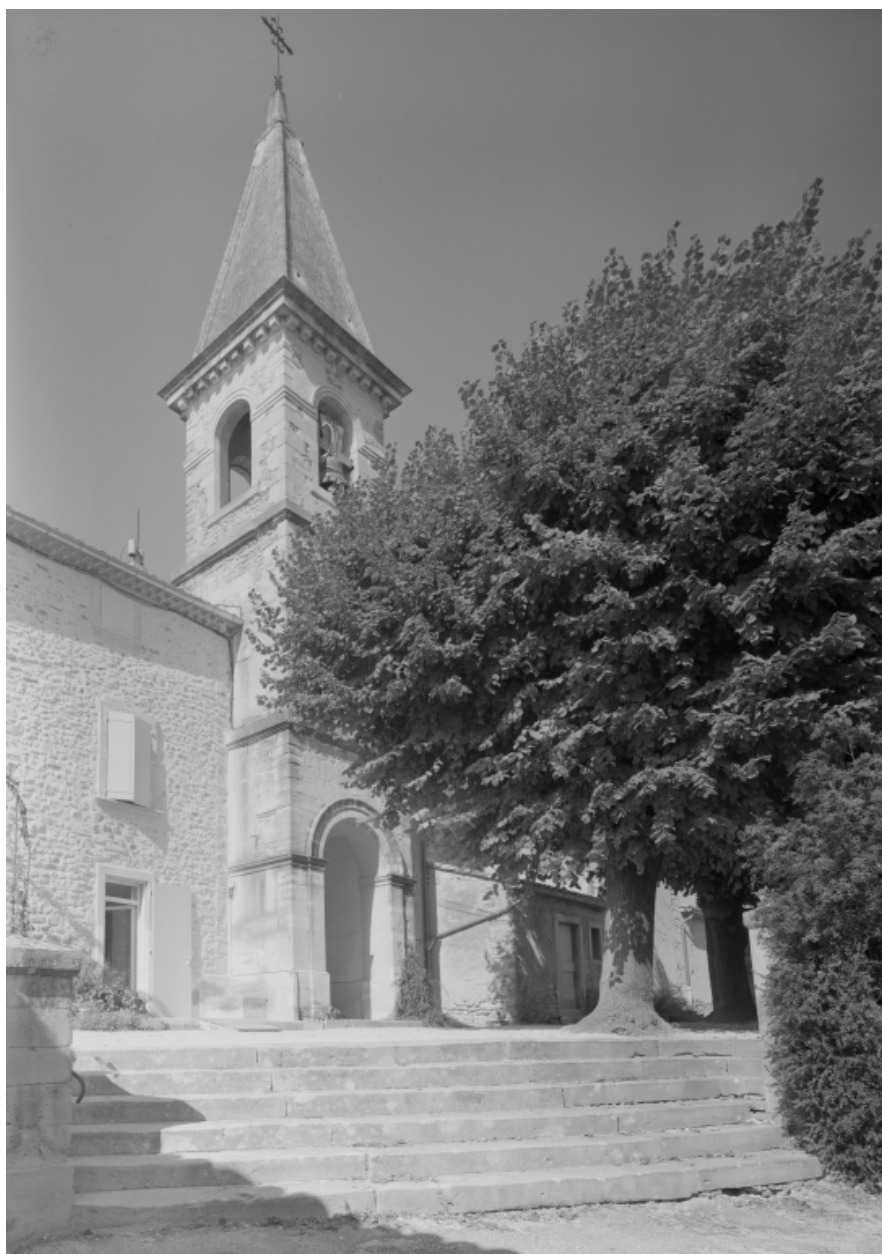
Vue du clocher-porche, depuis le sud.
