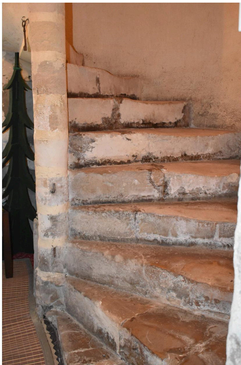
Vue de détail de l'escalier (tour d'escalier).
