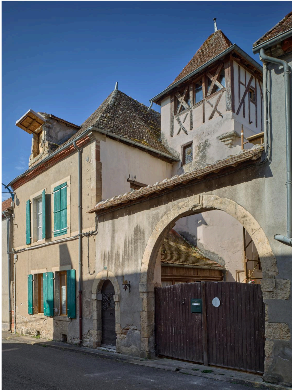
Vue générale de la façade latérale, de la porte piétonne et du porche d'accès à la cour.
