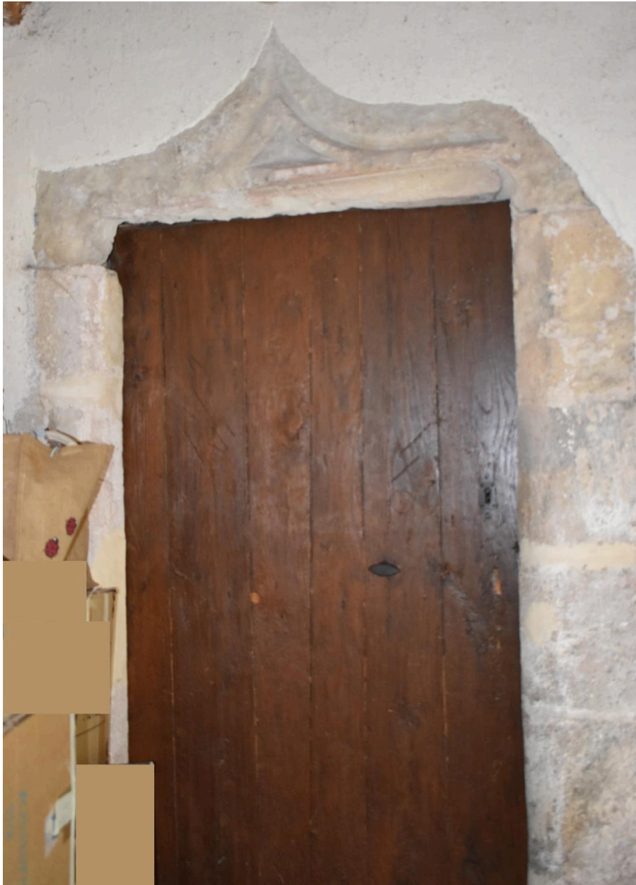
Vue de détail de la porte d'accès à la tour d'escalier.
