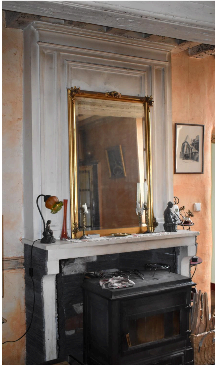
Détail de la cheminée ouest, adossée à la cheminée de la cuisine.
