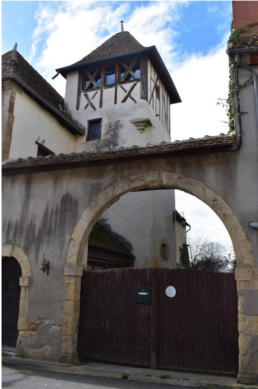
Vue du portail au premier plan et de la tour d'escalier au second plan.
