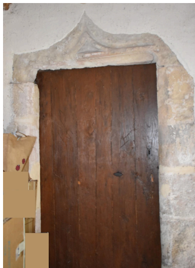
Vue de détail de la porte d'accès à la tour d'escalier. Phot. Maryse Durin-Tercelin IVR84_20250300601NUCA
