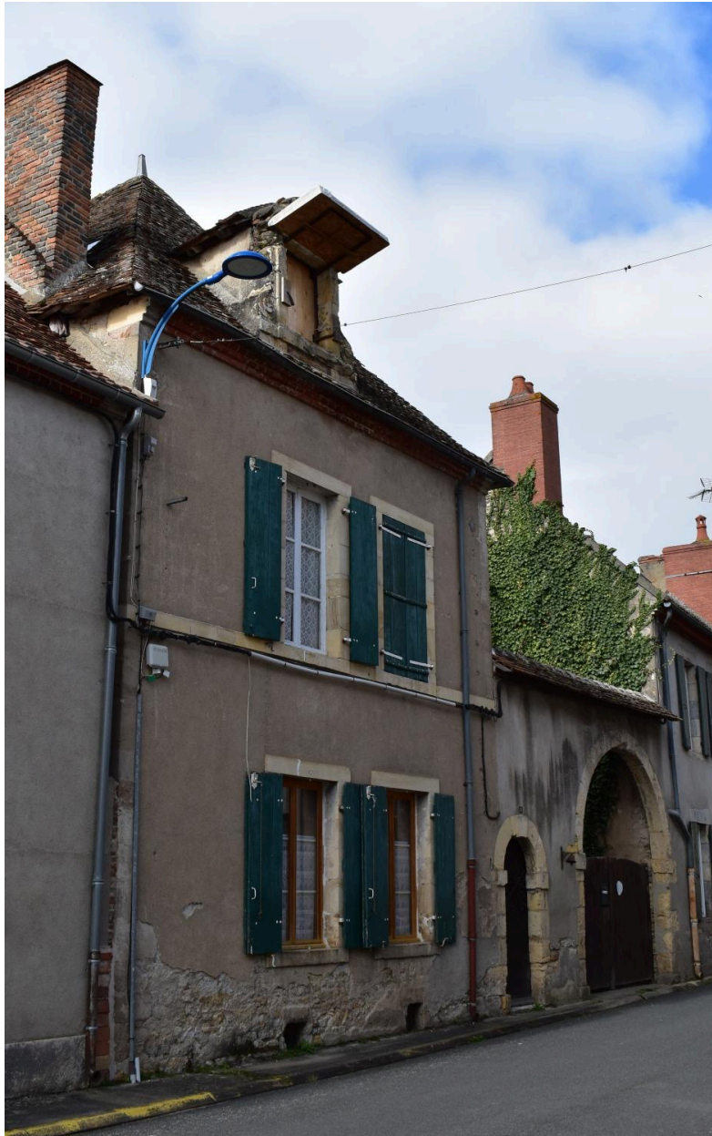
Vue générale de la façade latérale sur rue.
