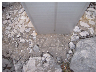
Vue de l'ancrage de la croix. Phot. Clémence Serve IVR82_20117400790NUCA
