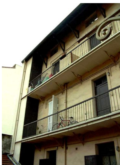
Détail de l'avant-toit au- dessus des coursières Phot. Bernard Ducouret IVR82_20006900551NUCA
