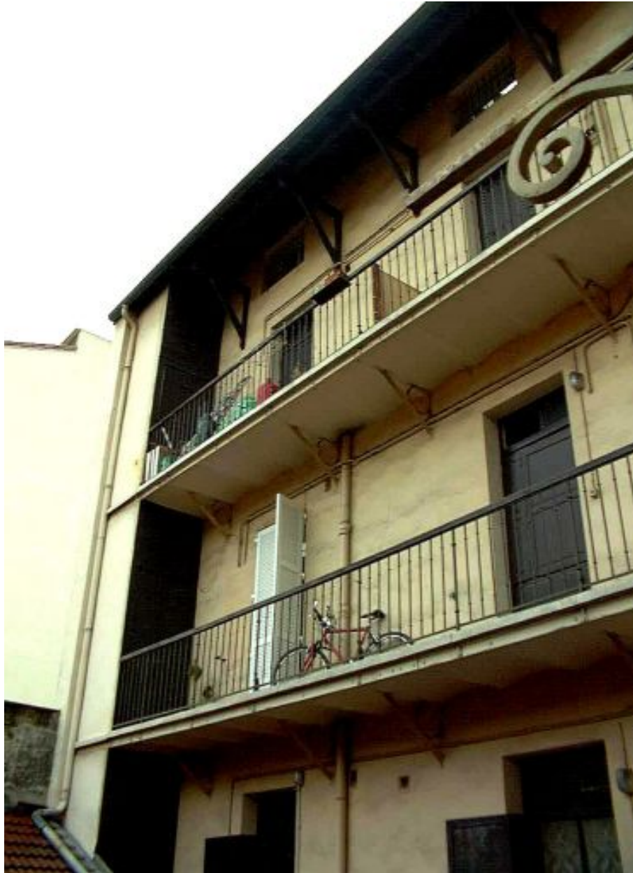
Détail de l'avant-toit au-dessus des coursières
