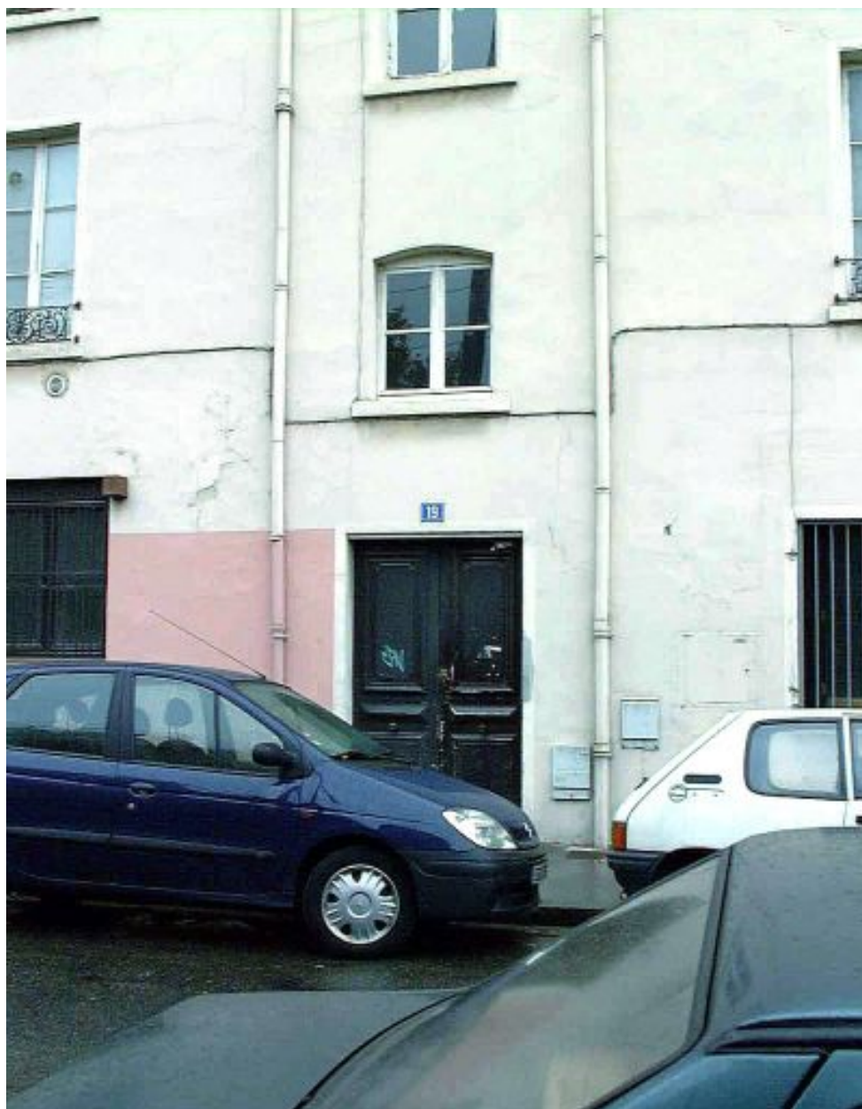
Détail de la porte d'entrée, rue Gillibert
