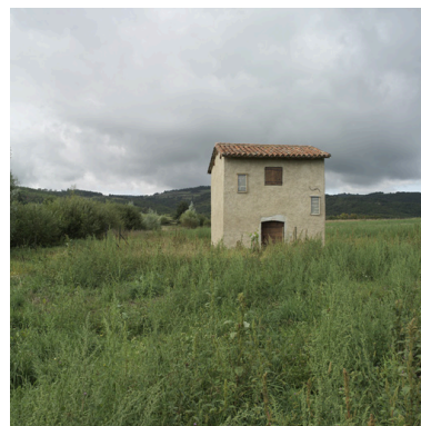
Vue générale. Phot. Eric Dessert IVR82_20074200872NUCA
