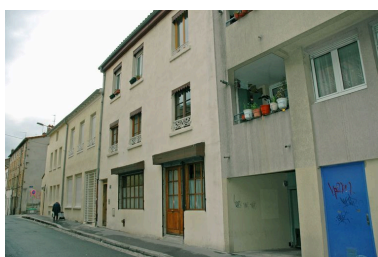
Accès à la rampe descendant au garage vue depuis le sud-ouest Phot. Maryannick Chalabi IVR82_20066901305NUCA
