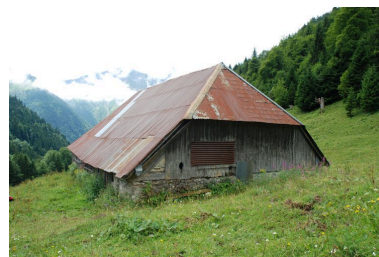
Vue du mur pignon nord derrière lequel se trouve la cave et l'ancien logis. Phot. Caroline Guibaud IVR82_20107304202NUCA
