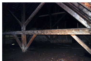
Vue de la charpente entre les allées de l'étable. Phot. Caroline Guibaud IVR82_20107304208NUCA
