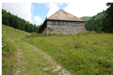
Vue du mur pignon sud. Phot. Caroline Guibaud IVR82_20107304210NUCA
