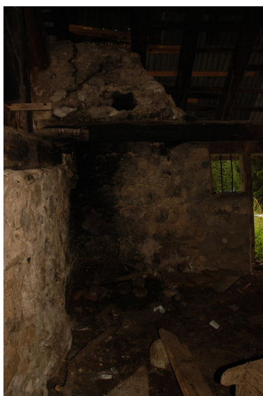
vue des restes de la cheminée à l'intérieur. Phot. Caroline Guibaud IVR82_20107304205NUCA
