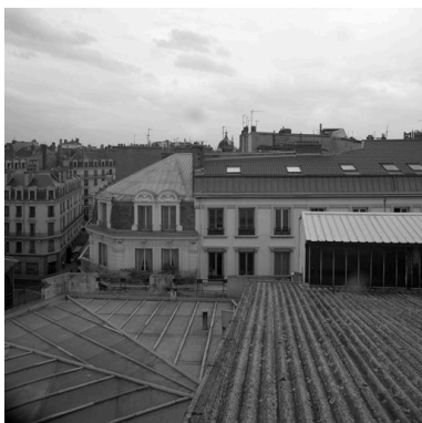
Derniers niveaux d'élévation rue Tupin depuis le toit du Grand Bazar Phot. Eric Dessert IVR82_20046901124NUC
