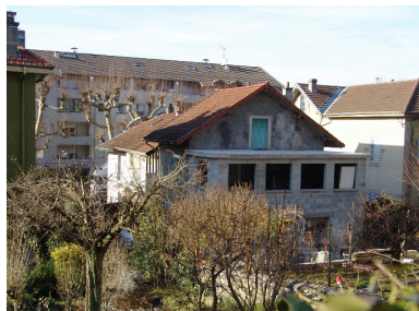
Vue générale prise de l'est Phot. François Fouger IVR82_20087300084NUCA
