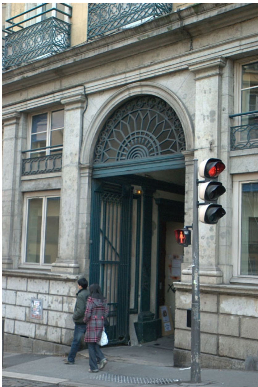
Entrée principale de l'immeuble Tassinari : détail tympan en ferronnerie
