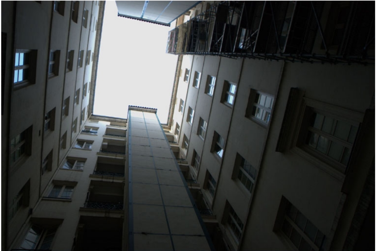
Façade intérieure : escalier et ascenseur
