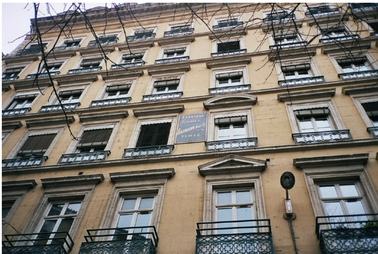
Détail façade est
