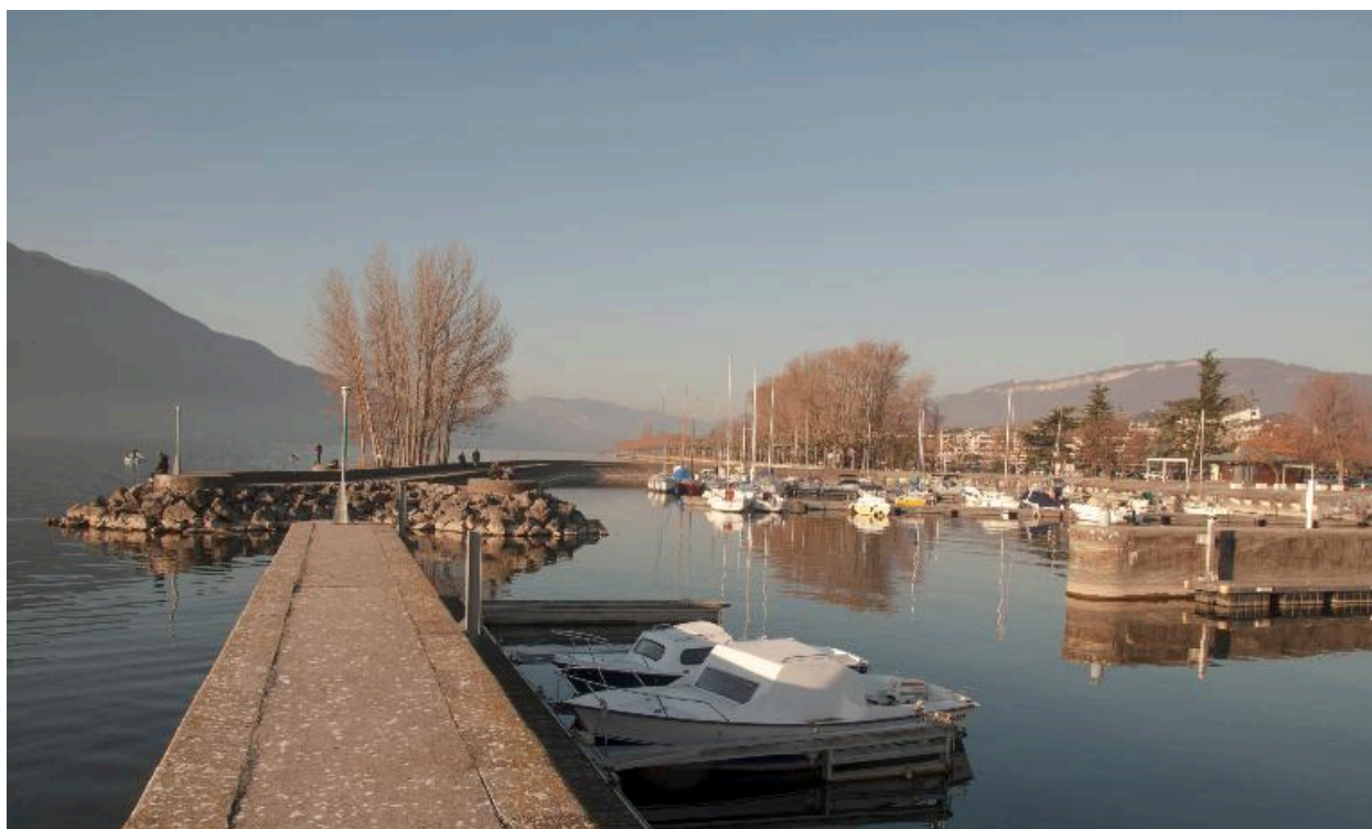
Bassin nord, créé en 1968 : vue en direction du nord
