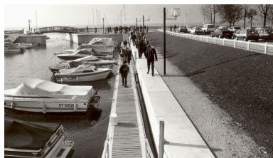
Ponton, inauguration en 1989 Repro. François Fouger IVR82_20117300890NUCB
