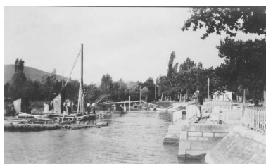
Travaux sur le lac, 1911 Repro. François Fouger IVR82_20117300875NUCB
