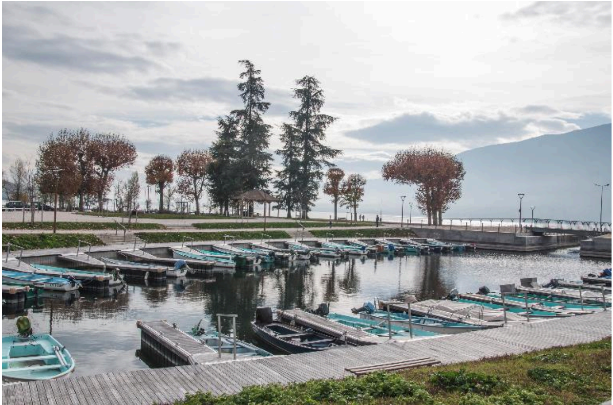
Bassin réouvert en 2012 : vue vers le sud
