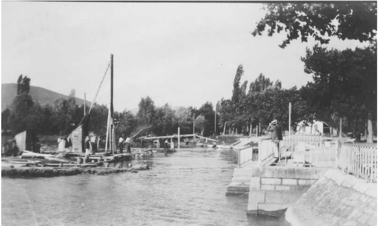
Travaux sur le lac, 1911
