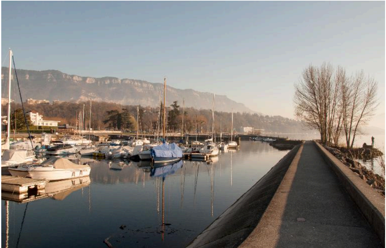
Bassin nord, créé en 1968 : vue en direction du sud
