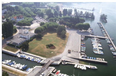
Vue aérienne, années 1990 Repro. Denys Harreau IVR84_20177300068NUCB
