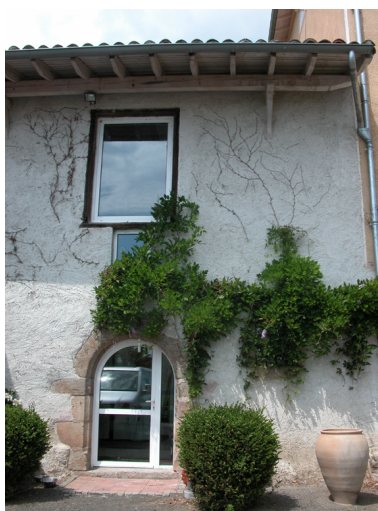
Ouvertures orientales du bâtiment ouest, accolé au donjon du côté sud. Phot. Thierry Monnet IVR82_20134200699NUCA
