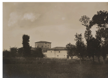
[Villeroy. Vue de la façade est]. Champdieu, Villeroy. Août 1910. Tirage argentique. B Diana Montrison. Fonds Brassart, liasse 5070 Phot. Eric (reproduction) Dessert IVR82_20084200185NUCA
