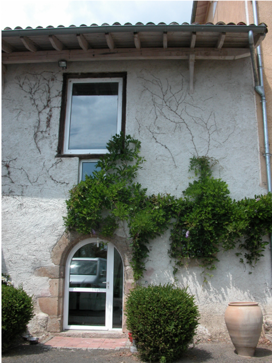
Ouvertures orientales du bâtiment ouest, accolé au donjon du côté sud.
