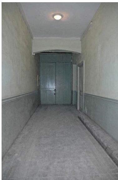
Vue intérieure : passage cocher Phot. Magali Delavenne IVR82_20146902842NUCA
