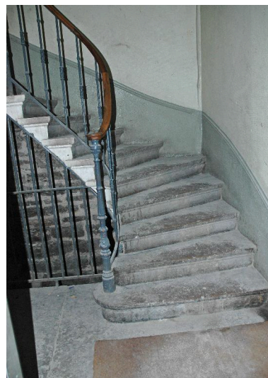
Vue intérieure : le départ de l'escalier Phot. Magali Delavenne IVR82_20146902843NUCA
