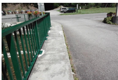
Pont des Canevières, vue de la chaussée et des rambardes Phot. Pascale Renard IVR84_20207401004NUCA
