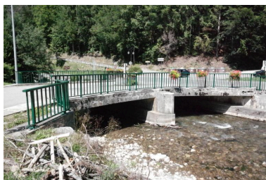
Vue générale du pont des Canevières Phot. Pascale Renard IVR84_20197401205NUCA
