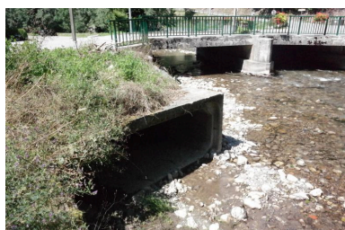
Pont des Canevières, vue sur face amont et sortie de canalisation Phot. Pascale Renard IVR84_20207401002NUCA
