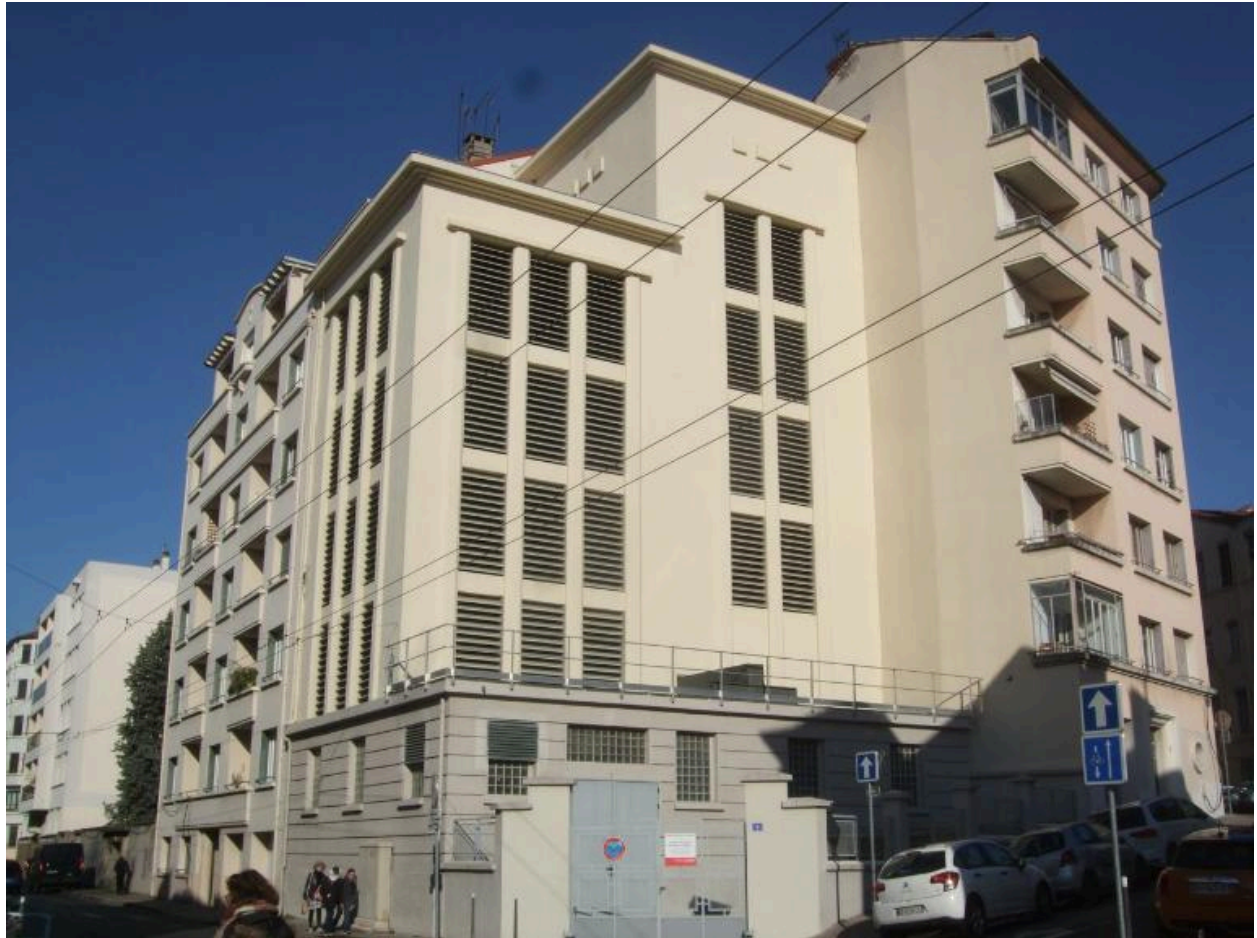
Vue d'ensemble de l'usine de ventilation 3 du tunnel de la Croix-Rousse.
