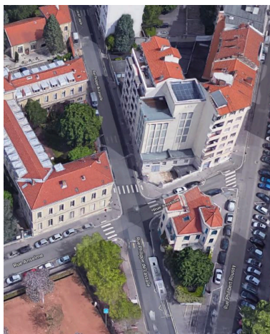
Vue zénitale google d'une des tours aérateur du tunnel de la Croix-Rousse. Phot. Nadine Halitim-Dubois IVR84_20186900051NUCA
