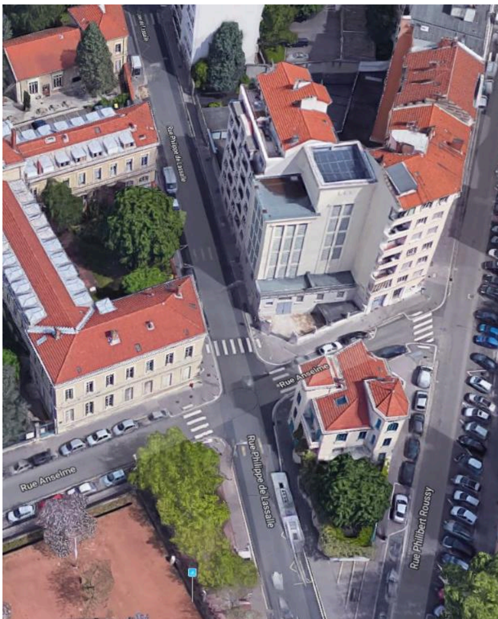
Vue zénitale google d'une des tours aérateur du tunnel de la Croix-Rousse.
