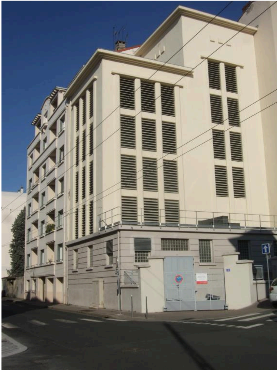
Vue d'ensemble de la tour de ventilation 2.
