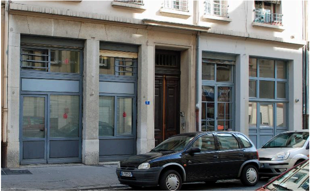
Elévation sur rue : vue rapprochée du rez-de-chaussée
