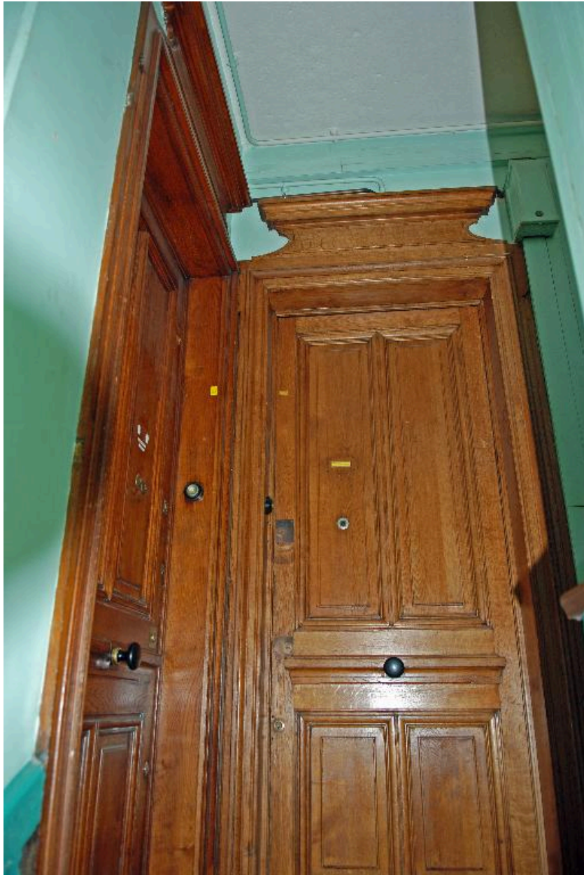
Vue intérieure : portes palières
