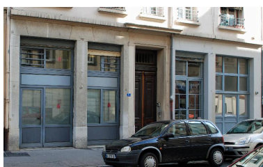
Elévation sur rue : vue rapprochée du rez-de-chaussée Phot. Magali Delavenne IVR82_20146902892NUCA
