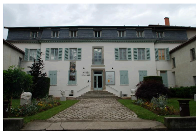
Vue du corps central côté cour. Phot. Jérôme Bellet IVR82_20154200317NUCA
