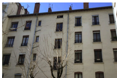
Vue de la façade postérieure sur cour Phot. Anaïs Beccaria IVR82_20046903190NUCA
