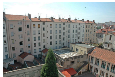
Elévations postérieures des 274-282 rue de Créqui Phot. Maryannick Chalabi IVR82_20066903146NUCA
