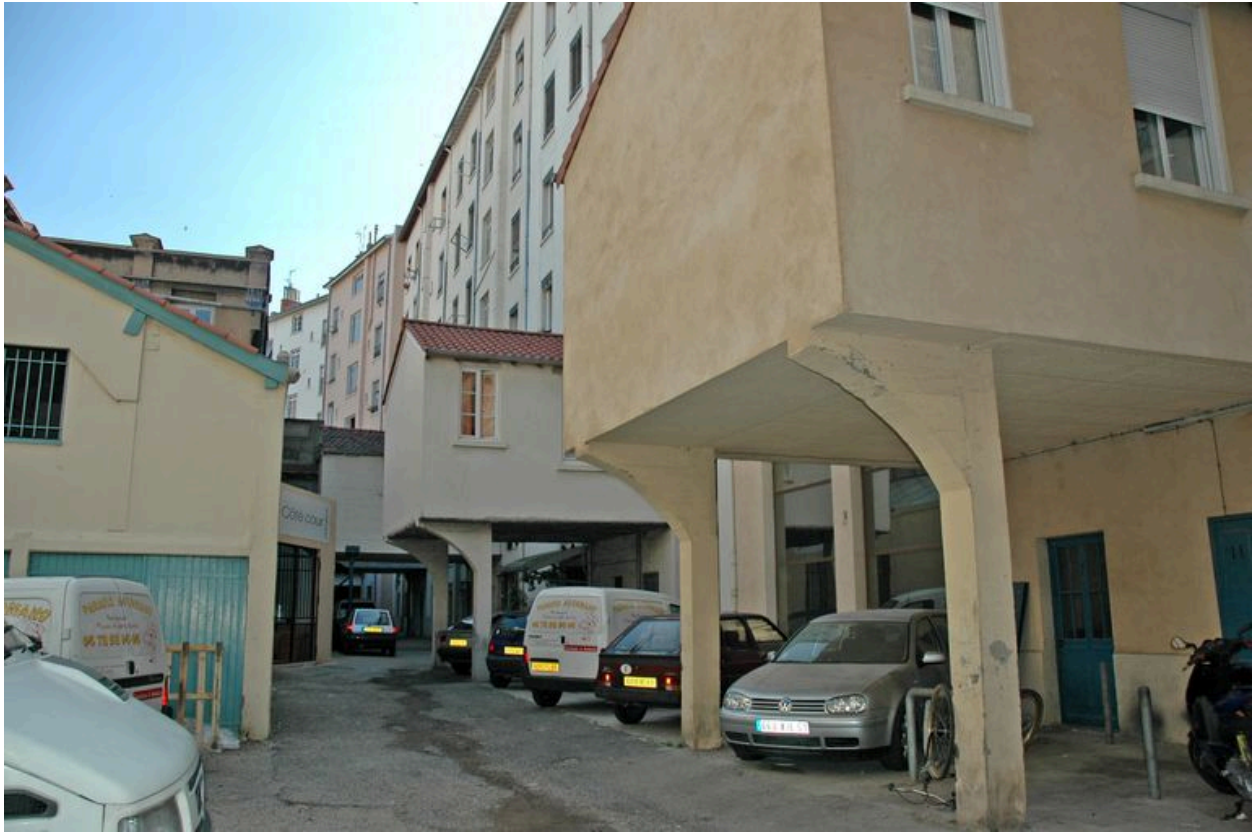
Détail des loges de concierge des 280 et 282 rue de Créqui
