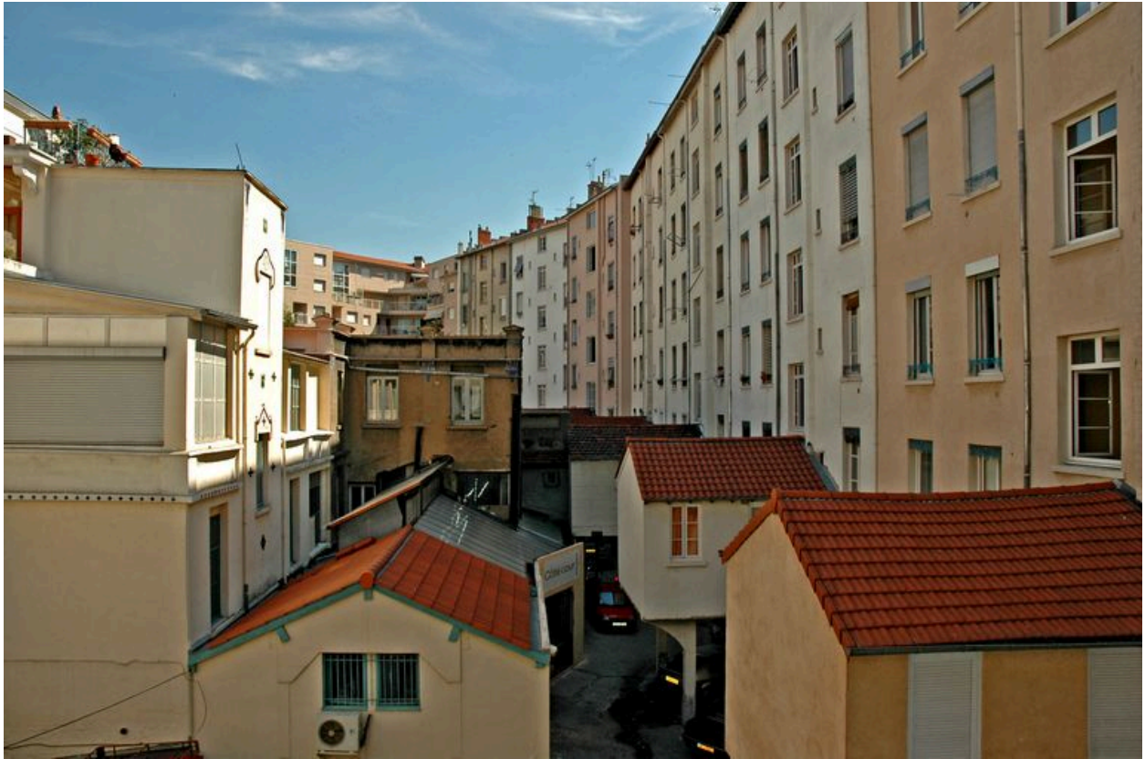
La cour depuis le sud et les loges de conciergerie en encorbellement
