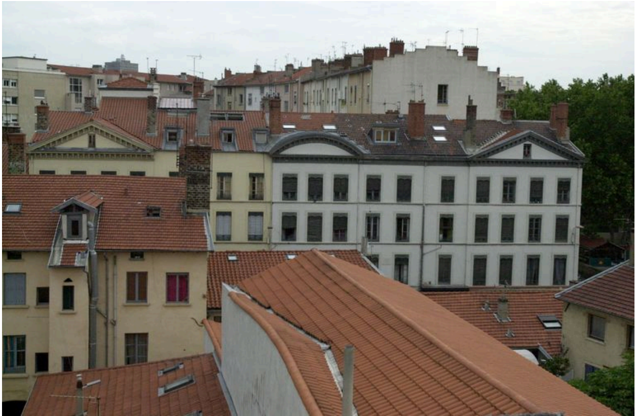
Vue d'ensemble des niveaux supérieurs depuis le sud-ouest
