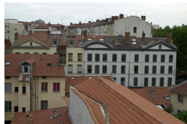
Vue d'ensemble des niveaux supérieurs depuis le sud-ouest Phot. Maryannick Chalabi IVR82_20096901149NUCA
