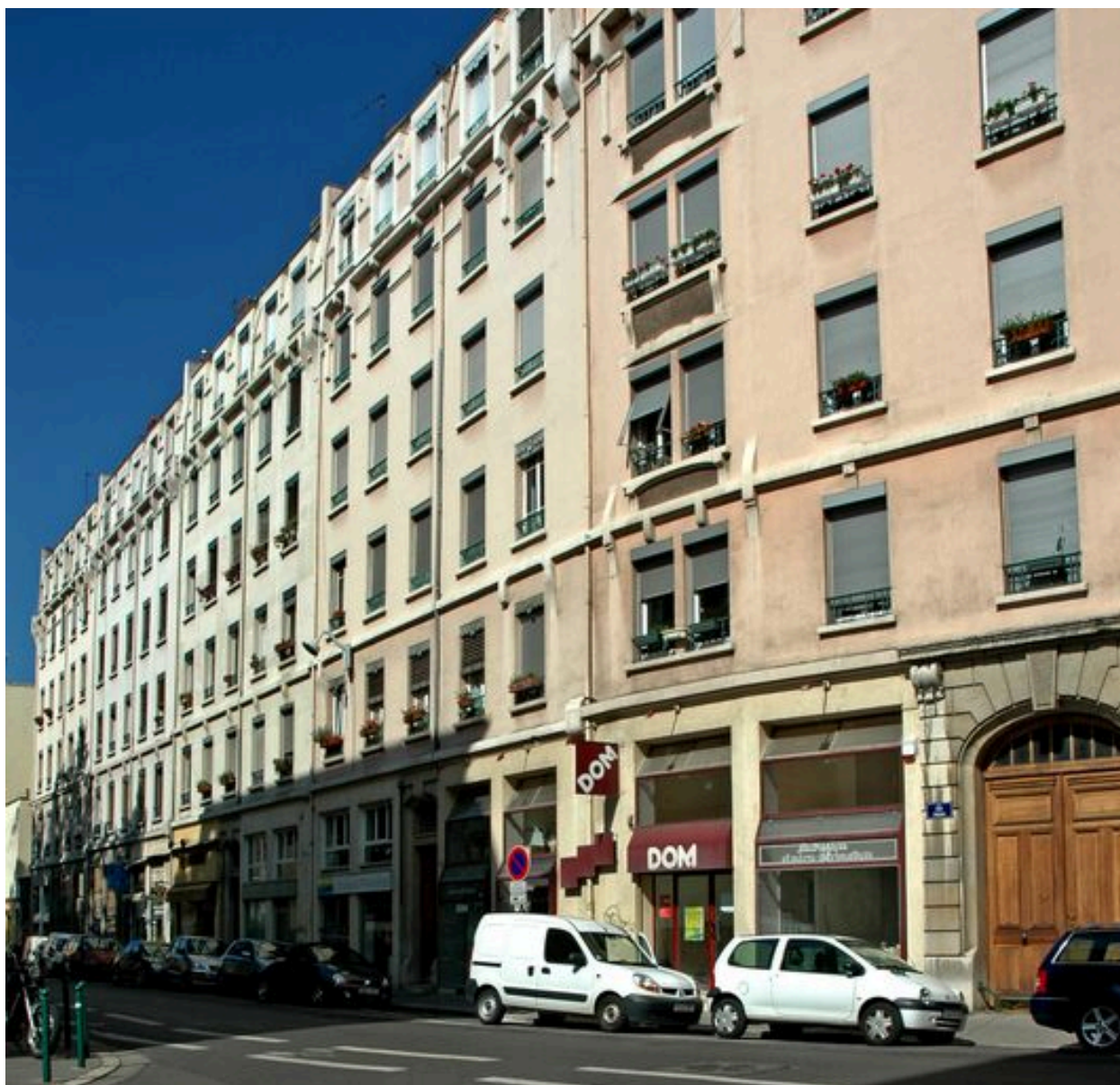
Vue d'ensemble des immeubles depuis le nord-est, à la hauteur du 274
