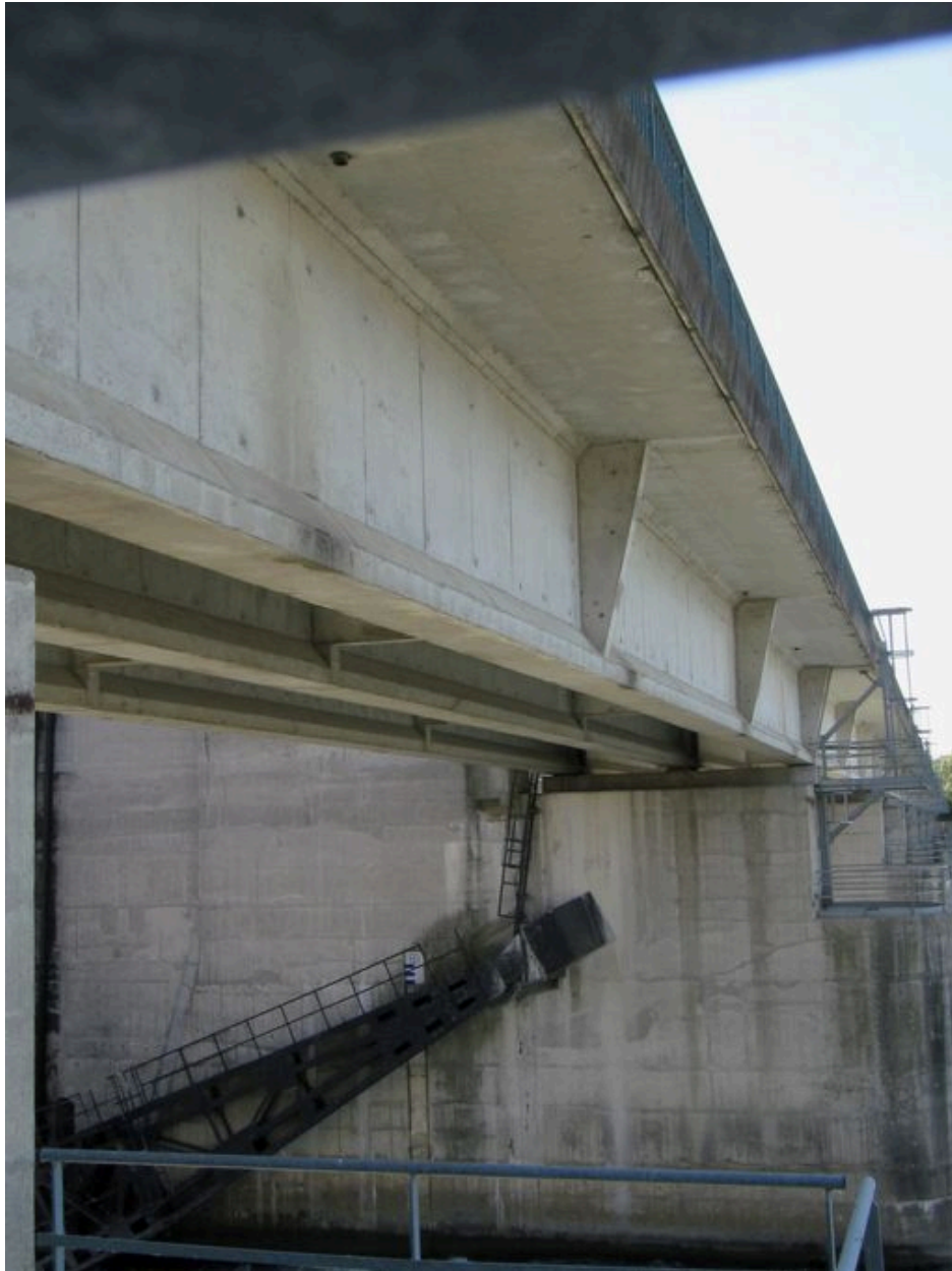
Pont routier aval, vue partielle face aval : tablier et parapet vus de dessous (depuis la rive droite)
