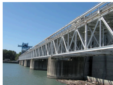
Passerelle amont, vue rapprochée : face amont (depuis la rive droite) Phot. I. Havard IVR82_20100700167NUCA
