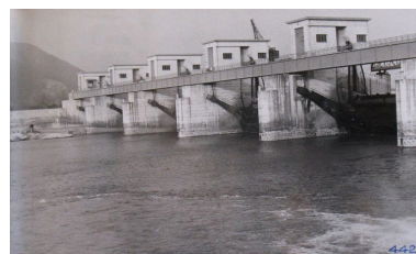
[Barrage de Donzère, construction du pont]. [1973]. 1 fotogr. pos. : n. et b. (AD Ardèche. 25 Fi 98, n°442) Phot. F. Bardoneschi, Autr. auteur inconnu 1_ IVR82_20100700071NUCAB
