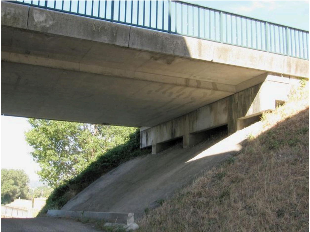
Pont routier aval, vue partielle face amont : culée de la rive droite
