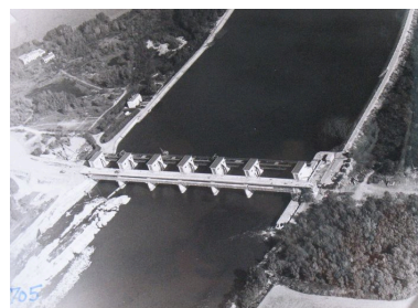
[Barrage de Donzère, construction du pont]. [1973]. 1 fotogr. pos. : n. et b. (AD Ardèche. 25 Fi 98, n°705) Phot. F. Bardoneschi, Autr. auteur inconnu 1_ IVR82_20100700073NUCAB
