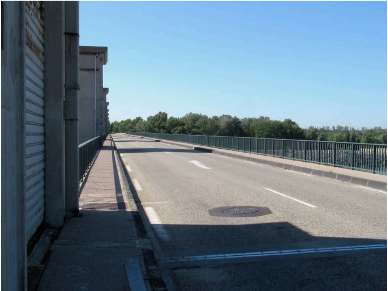
Pont routier aval, vue sur la chaussée (depuis la rive droite)
