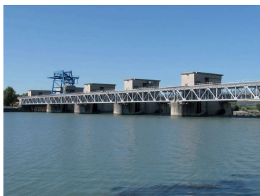
Vue générale, face amont (depuis la rive droite) Phot. I. Havard IVR82_20100700166NUCA
