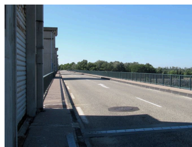
Pont routier aval, vue sur la chaussée (depuis la rive droite) Phot. I. Havard IVR82_20100700171NUCA
