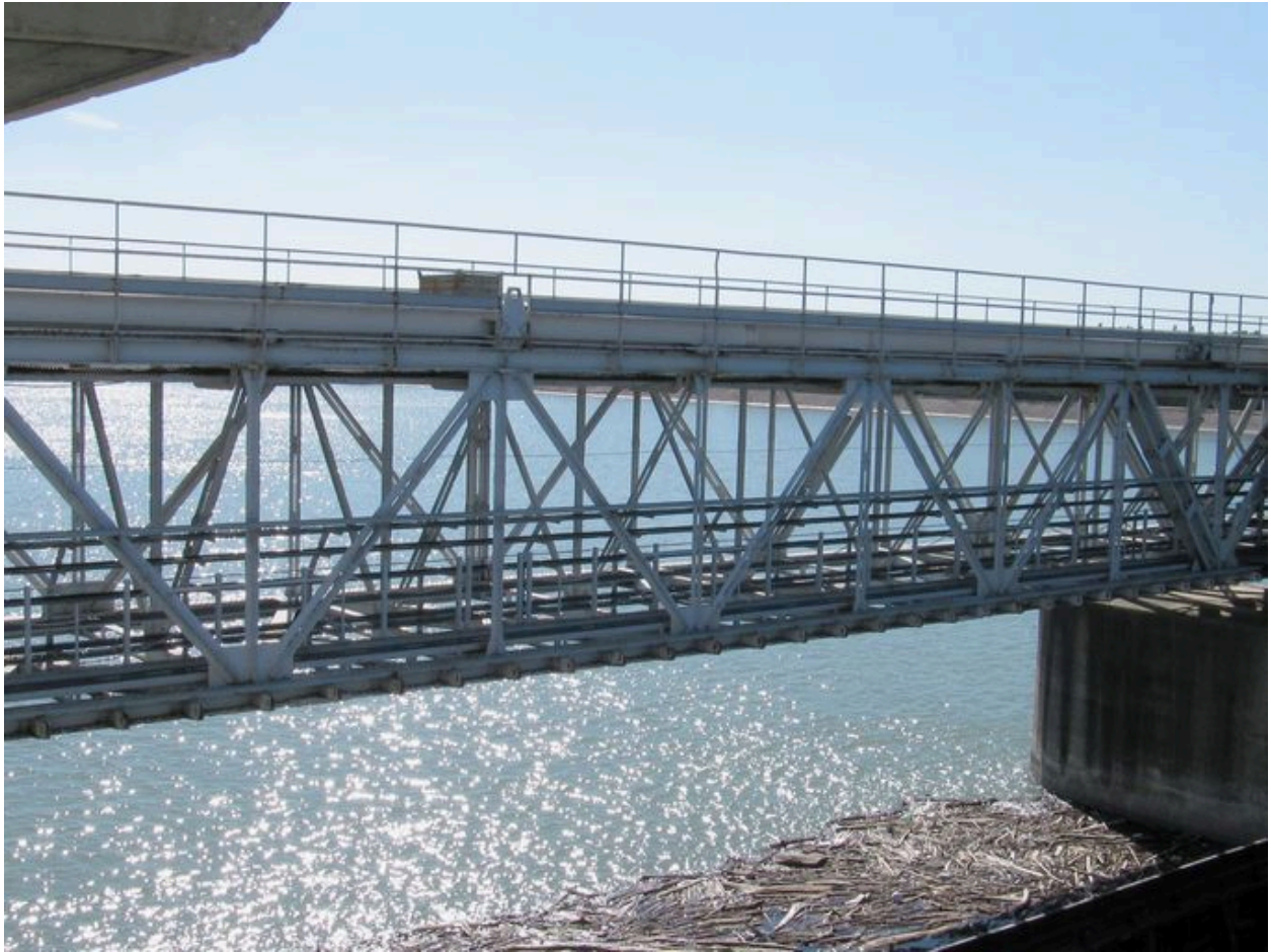
Passerelle amont, vue partielle du tablier (depuis la rive droite)
