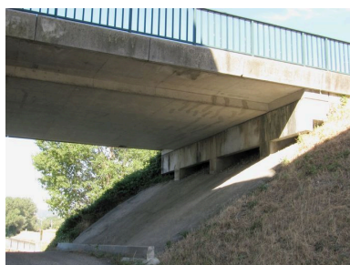
Pont routier aval, vue partielle face amont : culée de la rive droite Phot. I. Havard IVR82_20100700168NUCA
