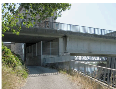
Pont routier aval, vue partielle face aval : travée de la rive droite Phot. I. Havard IVR82_20100700169NUCA
