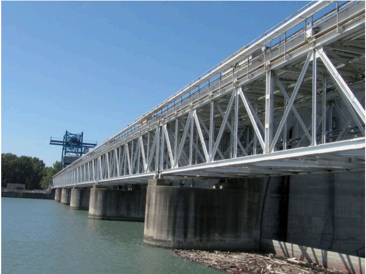
Passerelle amont, vue rapprochée : face amont (depuis la rive droite)
