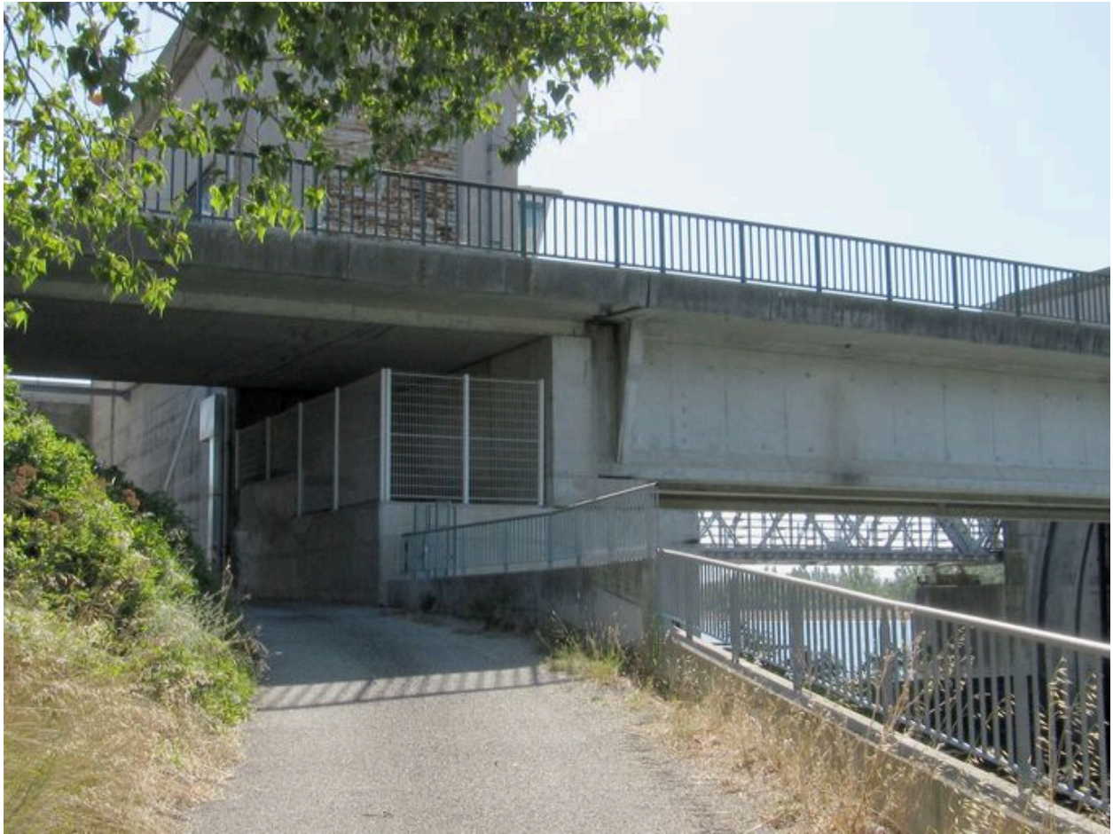
Pont routier aval, vue partielle face aval : travée de la rive droite
