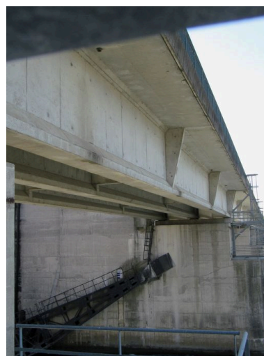
Pont routier aval, vue partielle face aval : tablier et parapet vus de dessous (depuis la rive droite) Phot. I. Havard IVR82_20100700170NUCA
