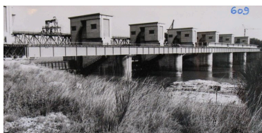
[Barrage de Donzère, construction du pont]. [1973]. 1 fotogr. pos. : n. et b. (AD Ardèche. 25 Fi 98, n°609) Phot. F. Bardoneschi, Autr. auteur inconnu 1_ IVR82_20102600052NUCAB
