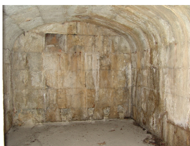
Division d'Enfer : douche verticale Phot. François Fouger IVR82_20047300375NUCA
