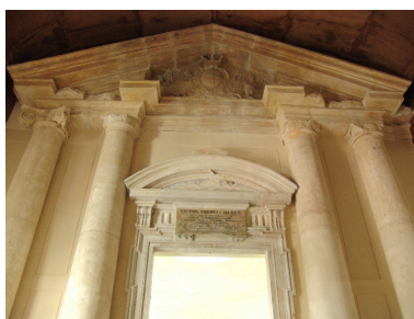
Façade du corps central après restauration Phot. François Fouger IVR82_20067300489NUCA
