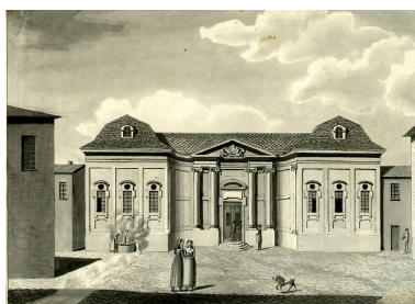
Vue d'ensemble Repro. François Fouger IVR82_20067300234NUCB
