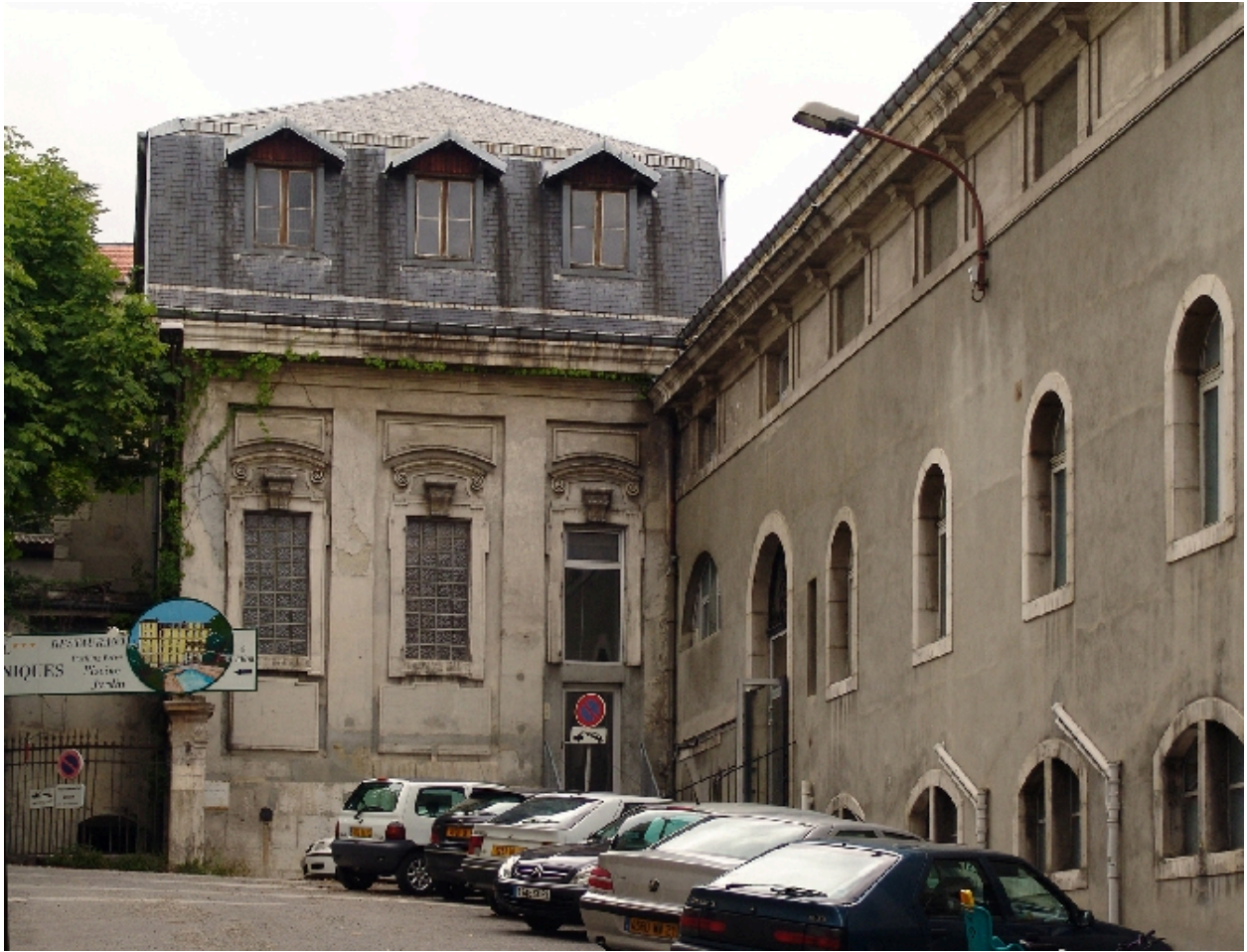
Façade, aile gauche
