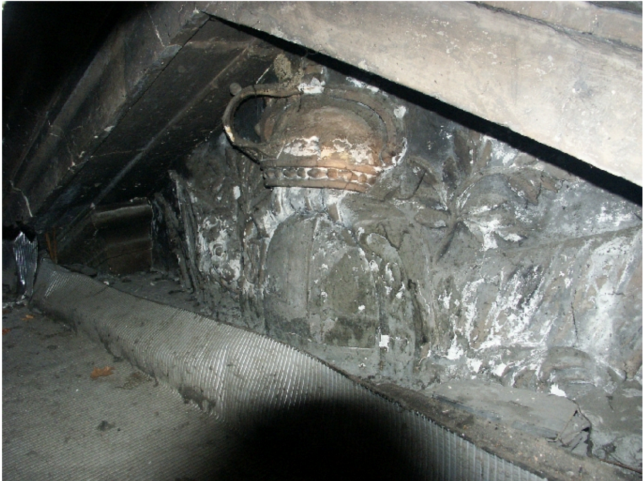
Fronton avant restauration
