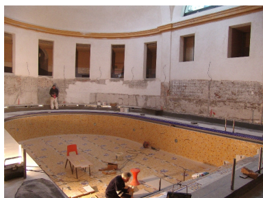
Piscine en cours de restauration Phot. François Fouger IVR82_20067300337NUCA
