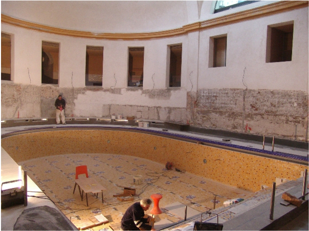
Piscine en cours de restauration
