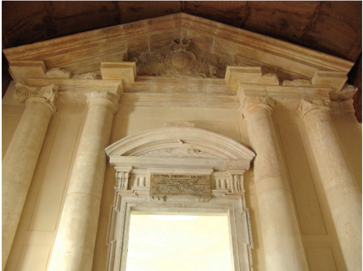
Façade du corps central après restauration
