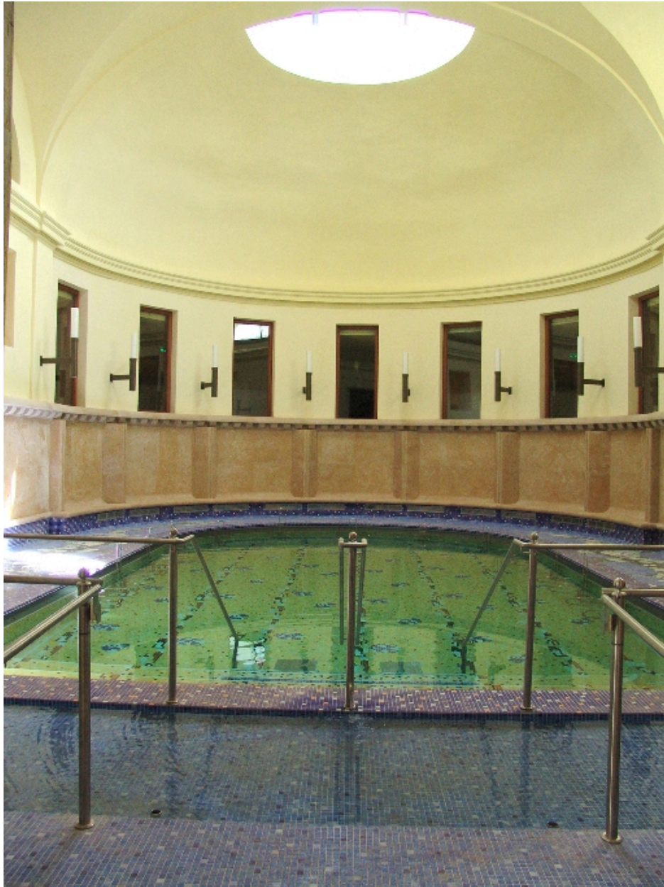
Piscine après restauration
