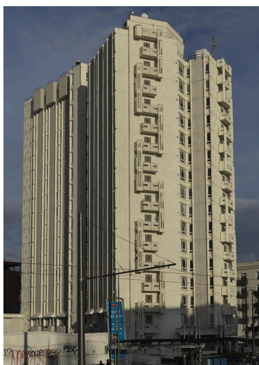
Vue d'ensemble Sud Phot. Thierry Leroy IVR82_20136903375NUCAQ
