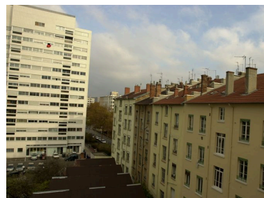
Vue de l'élévation postérieure depuis le sud-ouest Phot. Maryannick Chalabi IVR82_20086900646NUCA
