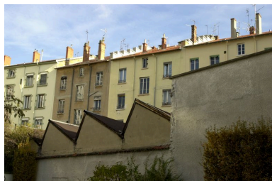
Détail des pignons découverts Phot. Maryannick Chalabi IVR82_20086900645NUCA
