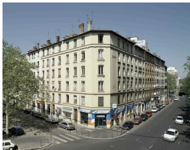
Vue d'ensemble depuis le sud-est Phot. Eric Dessert IVR82_20076902425NUCA
