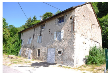
Elevation Sud-Ouest du bâtiment du moulin Phot. Samir Mahfoudi, Autr. Samir Mahfoudi IVR82_20107400295NUCA
