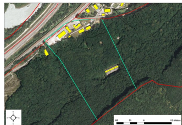
Vue aérienne du domaine des Eaux-Belles Phot. Samir Mahfoudi, Autr. Samir Mahfoudi IVR82_20107400296NUCA
