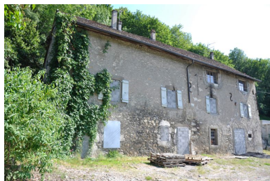
Vue générale Phot. Samir Mahfoudi, Autr. Samir Mahfoudi IVR82_20107400293NUCA
