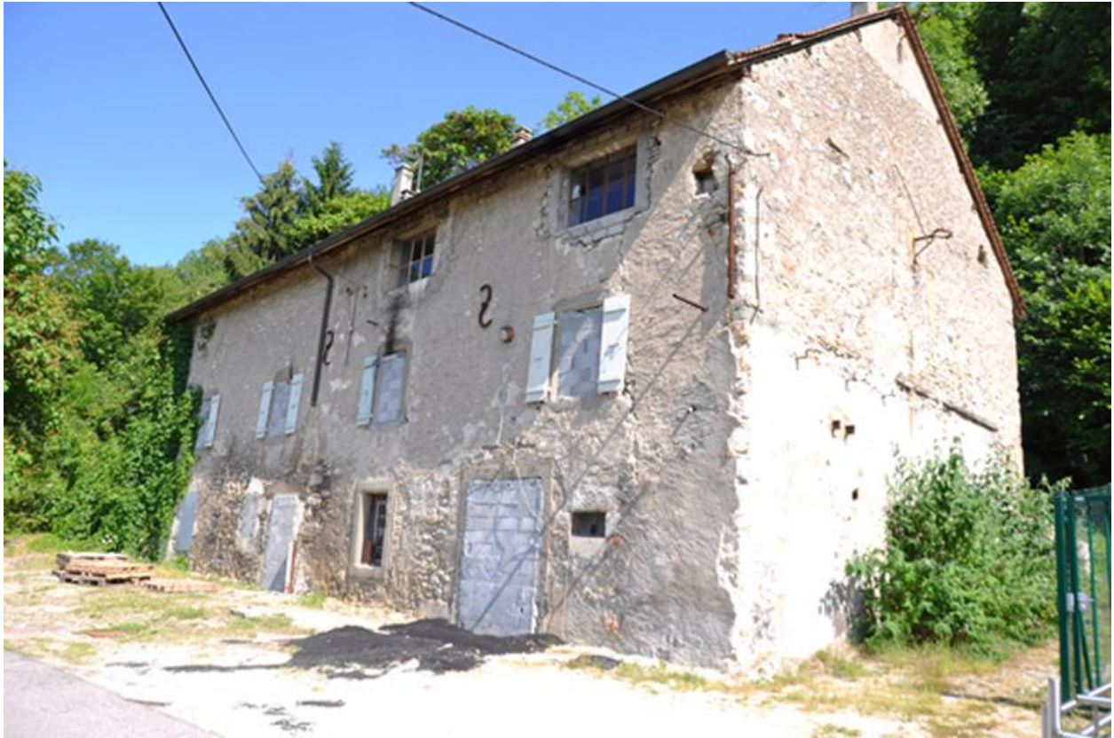
Elevation Sud-Ouest du bâtiment du moulin
