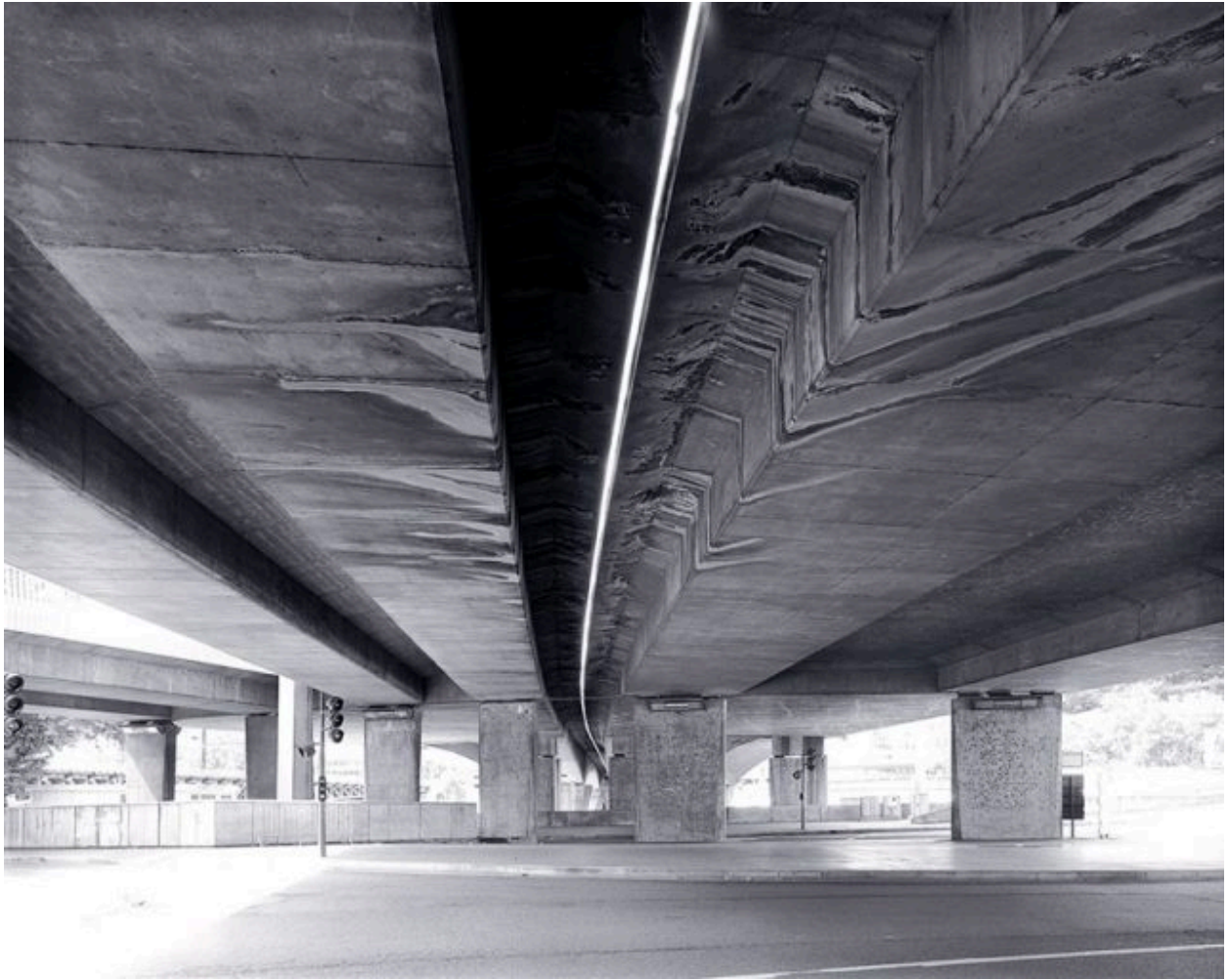
Vue du dessous du tablier
