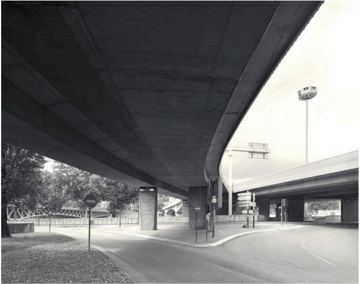
Vue d'ensemble des piles et du dessous du pont depuis l'est
