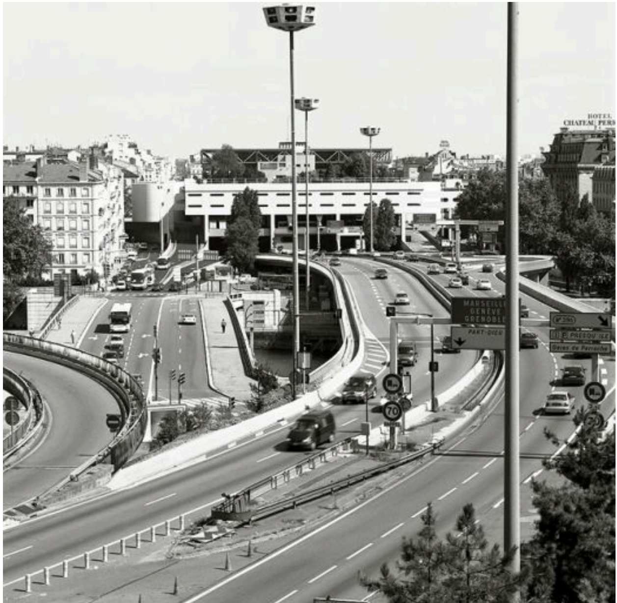
Vue d'ensemble depuis la tour du tunnel de Fourvière
