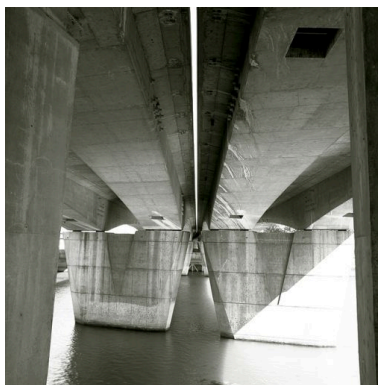
Détail du dessous des arches du pont depuis la rivière Phot. Didier Gourbin IVR82_20026903805X
