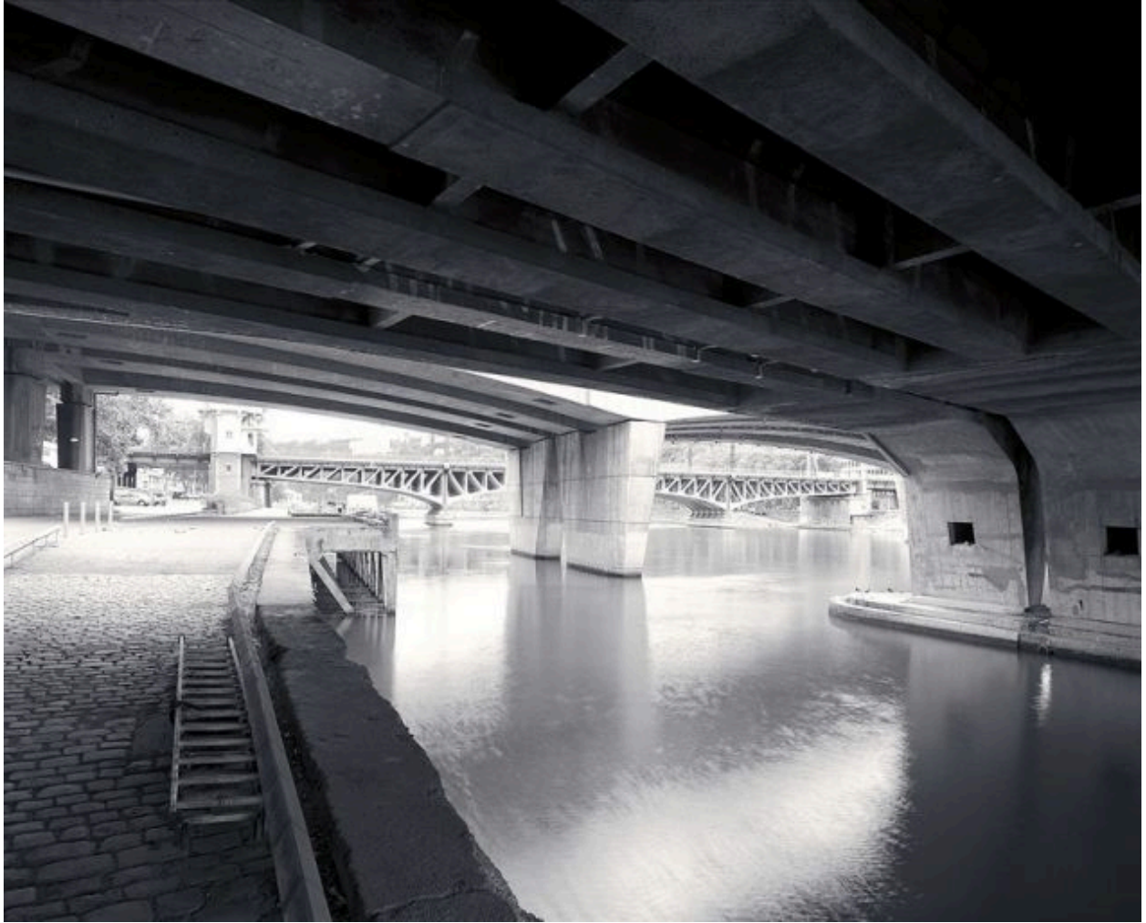
Le dessous du pont depuis le quai au nord
