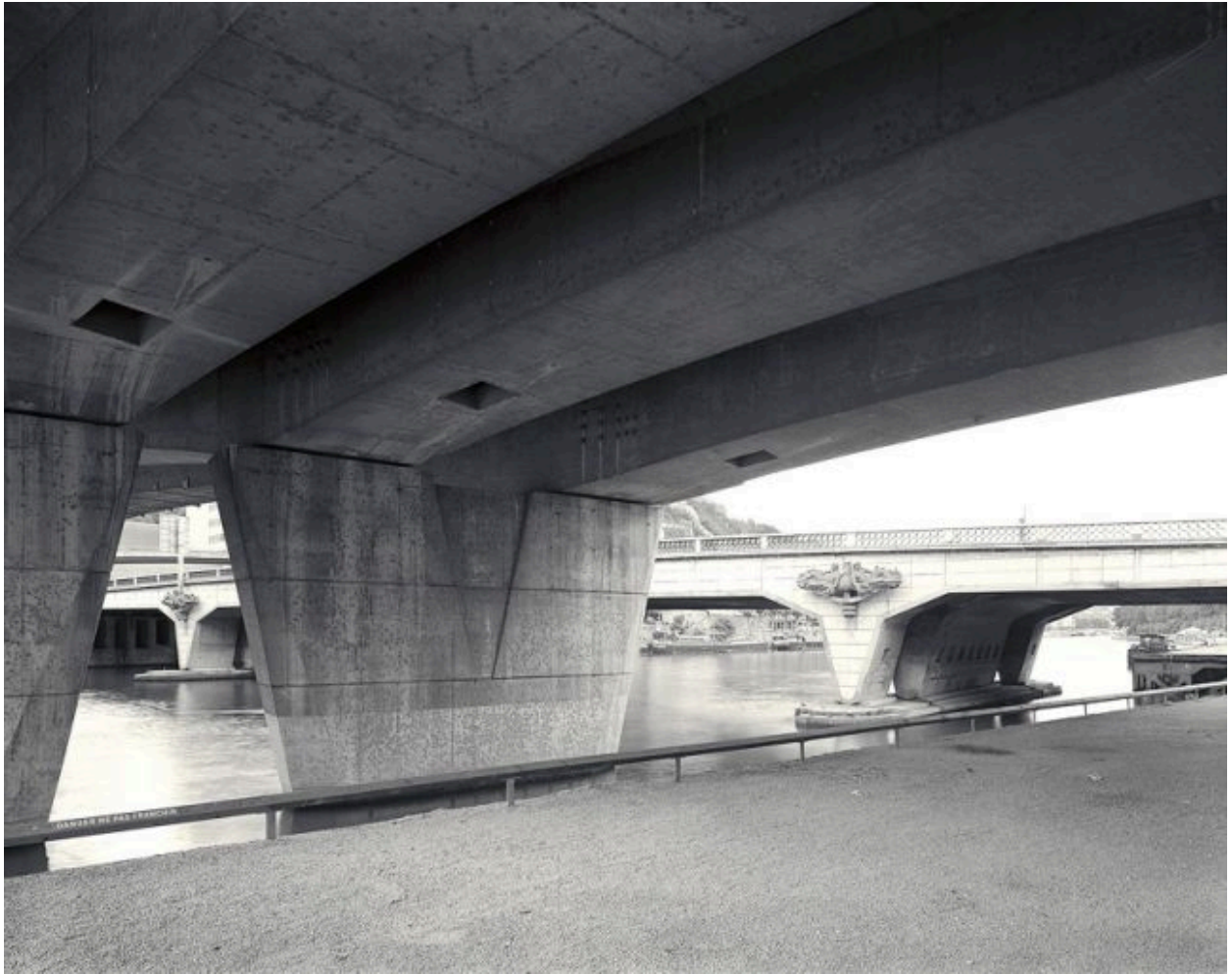
Piles et arches du pont, avec le pont Kitchener-Marchand au nord
