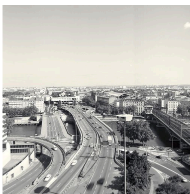
Vue d'ensemble depuis le tunnel de Fourvière, à l'ouest Phot. Eric Dessert IVR82_20026903639X
