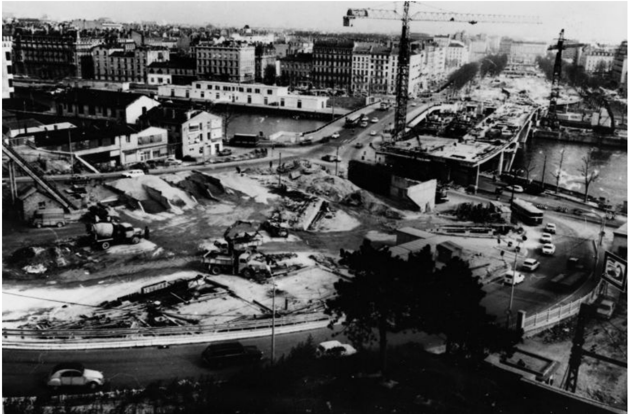
Construction du pont autoroutier sur la Saône, fotogr., [1971]
