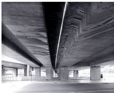
Vue du dessous du tablier Phot. Eric Dessert IVR82_20026903674V
