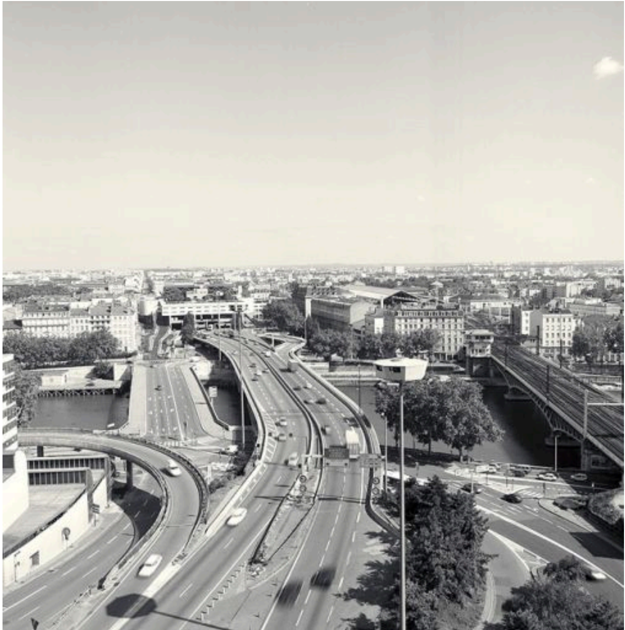
Vue d'ensemble depuis le tunnel de Fourvière, à l'ouest
