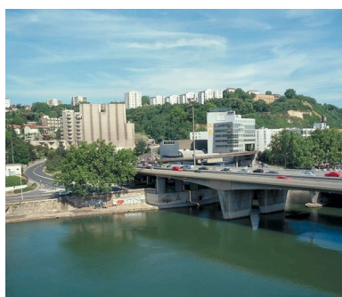
Vue d'ensemble du pont et de l'entrée du tunnel sous Fourvière depuis le poste d'aiguillage 1 de Lyon-Perrache Phot. Eric Dessert IVR82_20026903506XA
