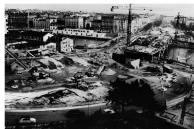
Construction du pont autoroutier sur la Saône, fotogr., [1971] IVR82_20026900129NUCB
