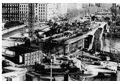
Construction du pont autoroutier sur la Saône, fotogr., [1971] IVR82_20026900130NUCB
