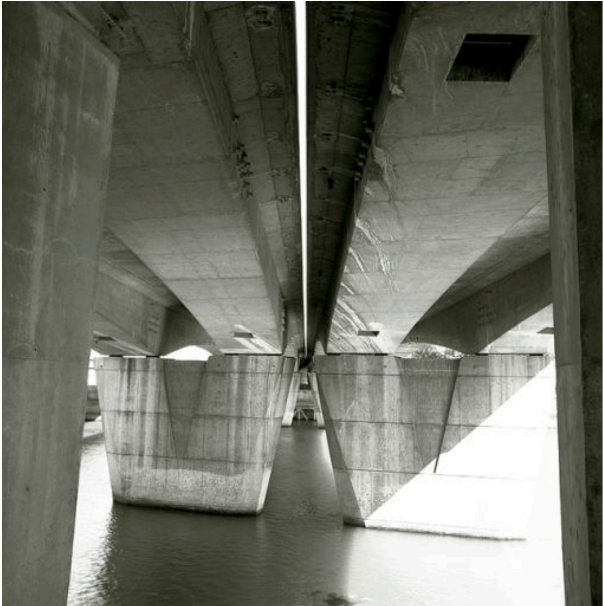
Détail du dessous des arches du pont depuis la rivière
