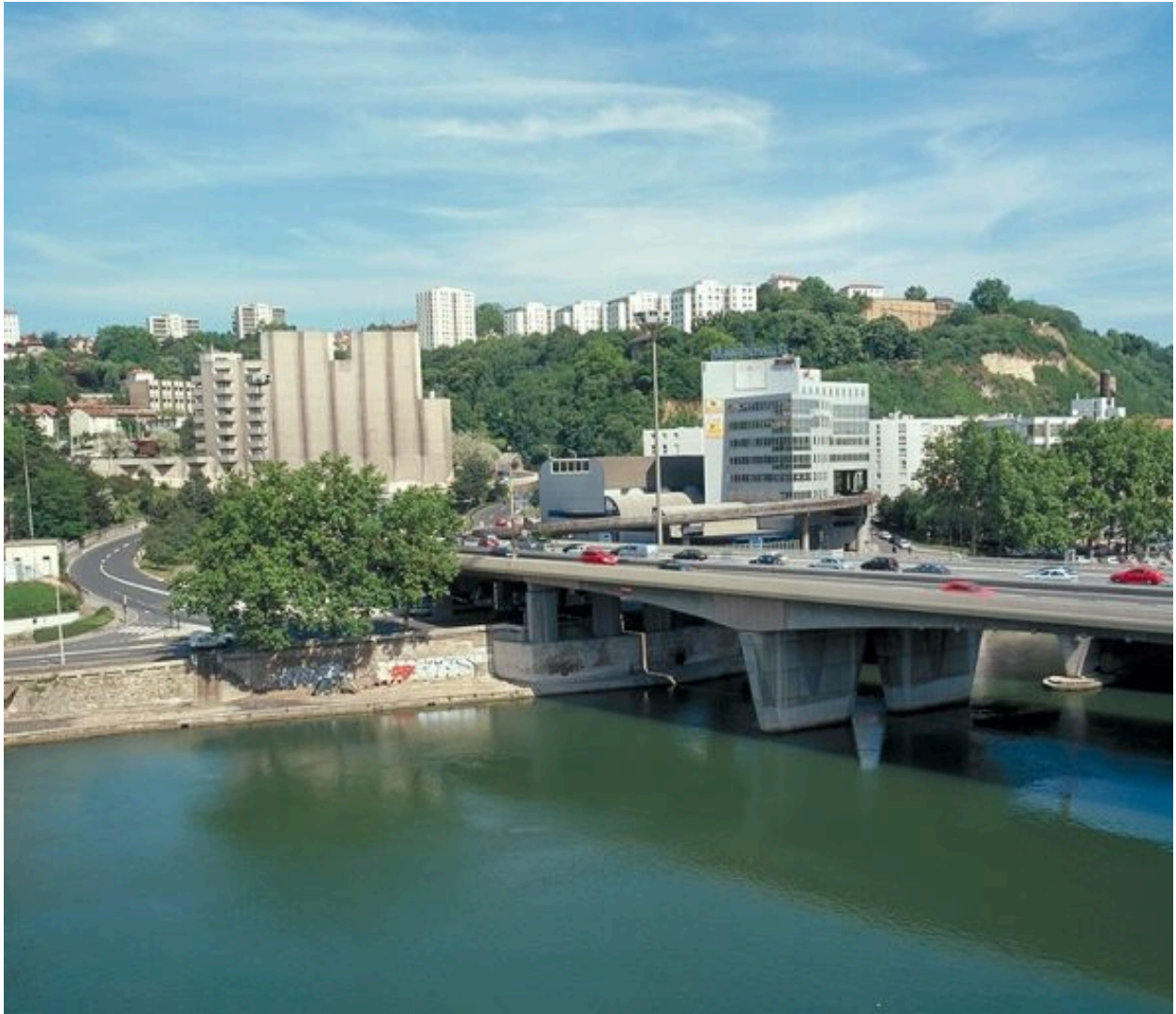
Vue d'ensemble du pont et de l'entrée du tunnel sous Fourvière depuis le poste d'aiguillage 1 de Lyon-Perrache
