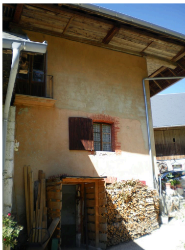
Façade sud qui correspond peut-être à l'ancienne façade principale. Phot. Clémence Serve IVR82_20117400901NUCA
