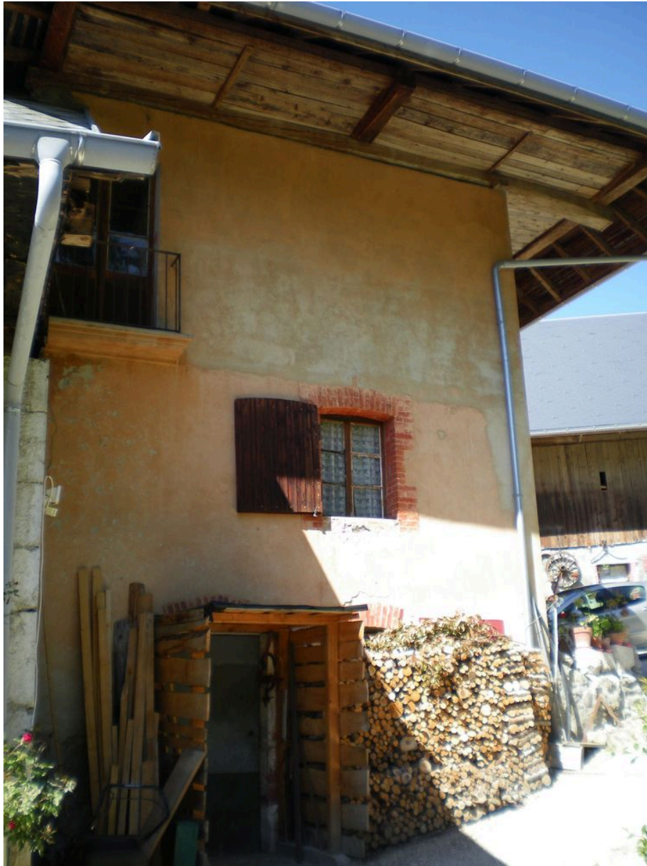
Façade sud qui correspond peut-être à l'ancienne façade principale.
