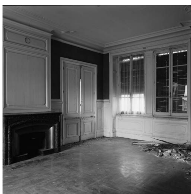
Premier étage : vue générale de la pièce de réception sud de l'appartement principal Phot. Didier Gourbin IVR82_20036903247X
