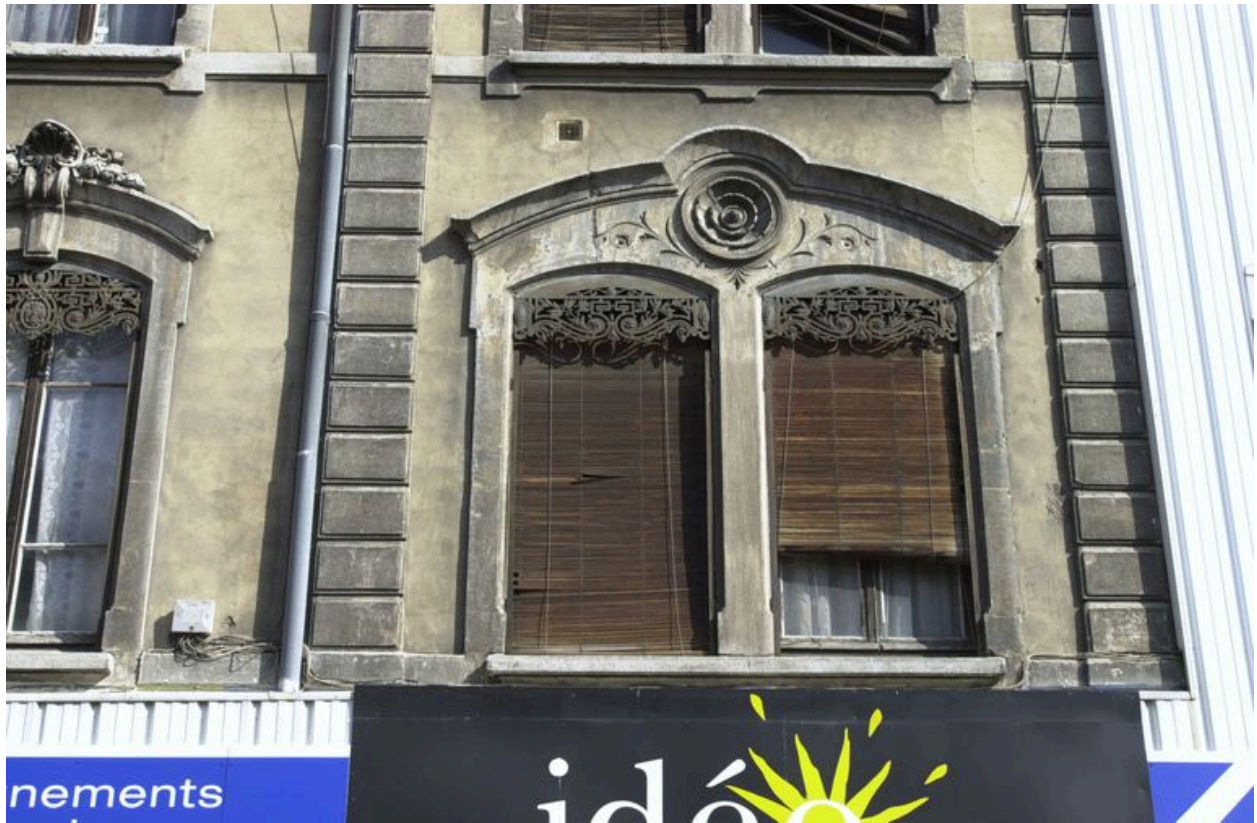
Fenêtres de la travée droite du premier étage carré
