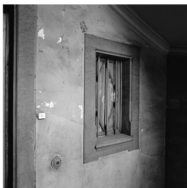
Cage d'escalier : fenêtre de second jour éclairant un appartement Phot. Didier Gourbin IVR82_20036903261X
