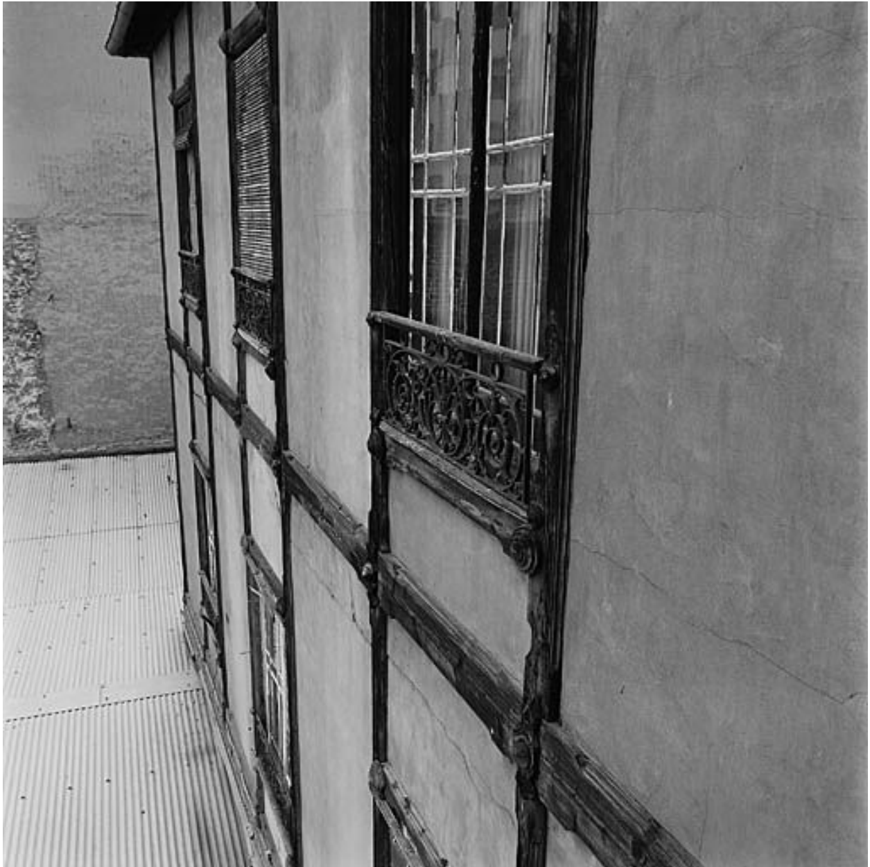
Vue partielle de l'élévation postérieure (1er et 2e étages)
