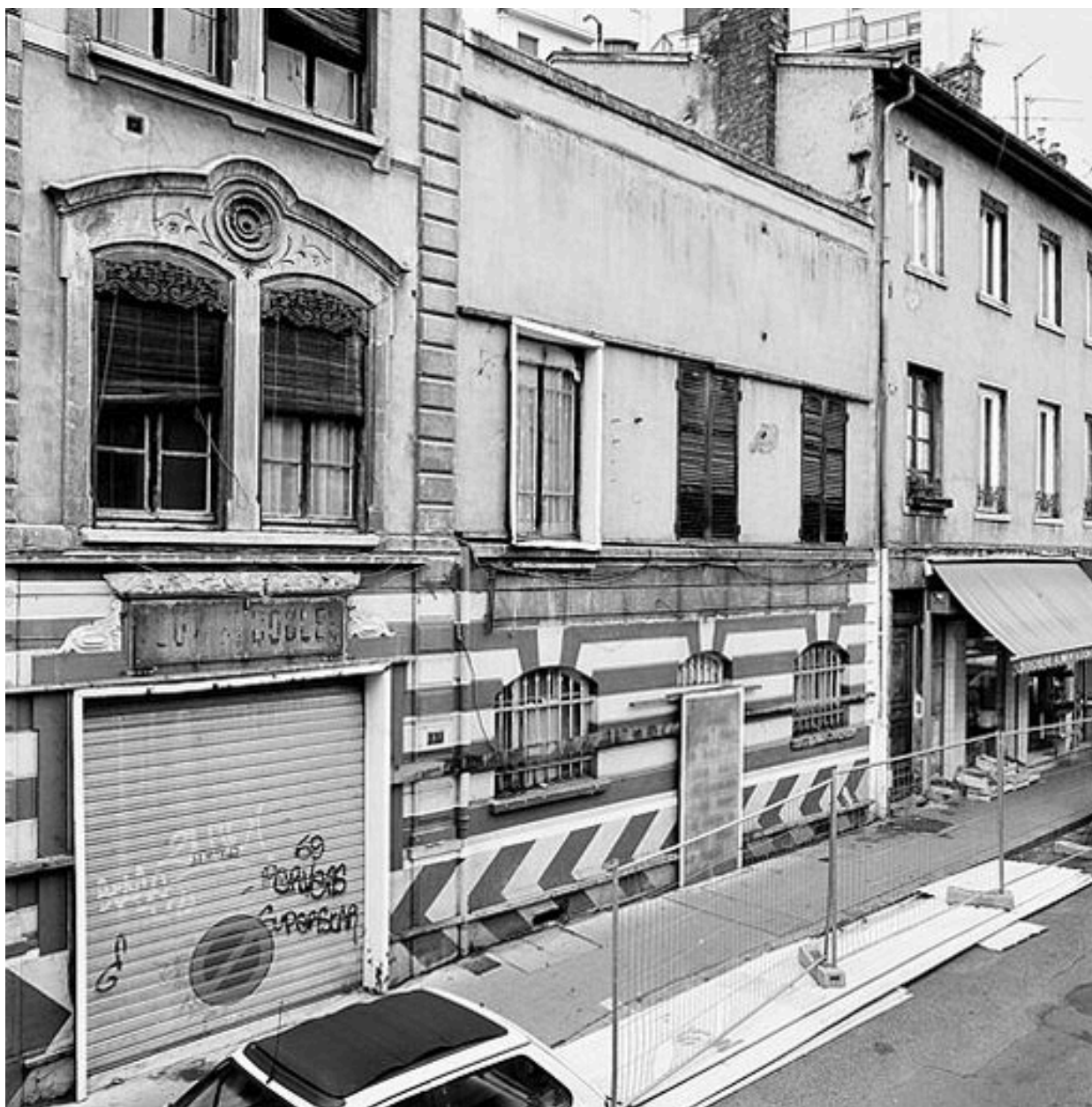
Elévation antérieure de la partie droite de la maison, après enlèvement du bardage métallique
