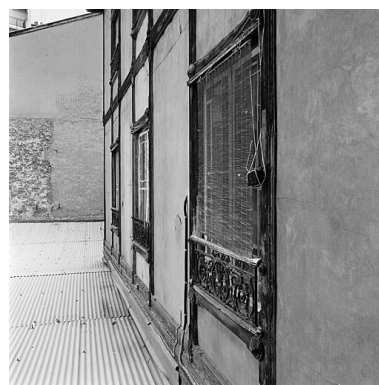
L'élévation postérieure vue depuis le premier étage Phot. Didier Gourbin IVR82_20036903260X
