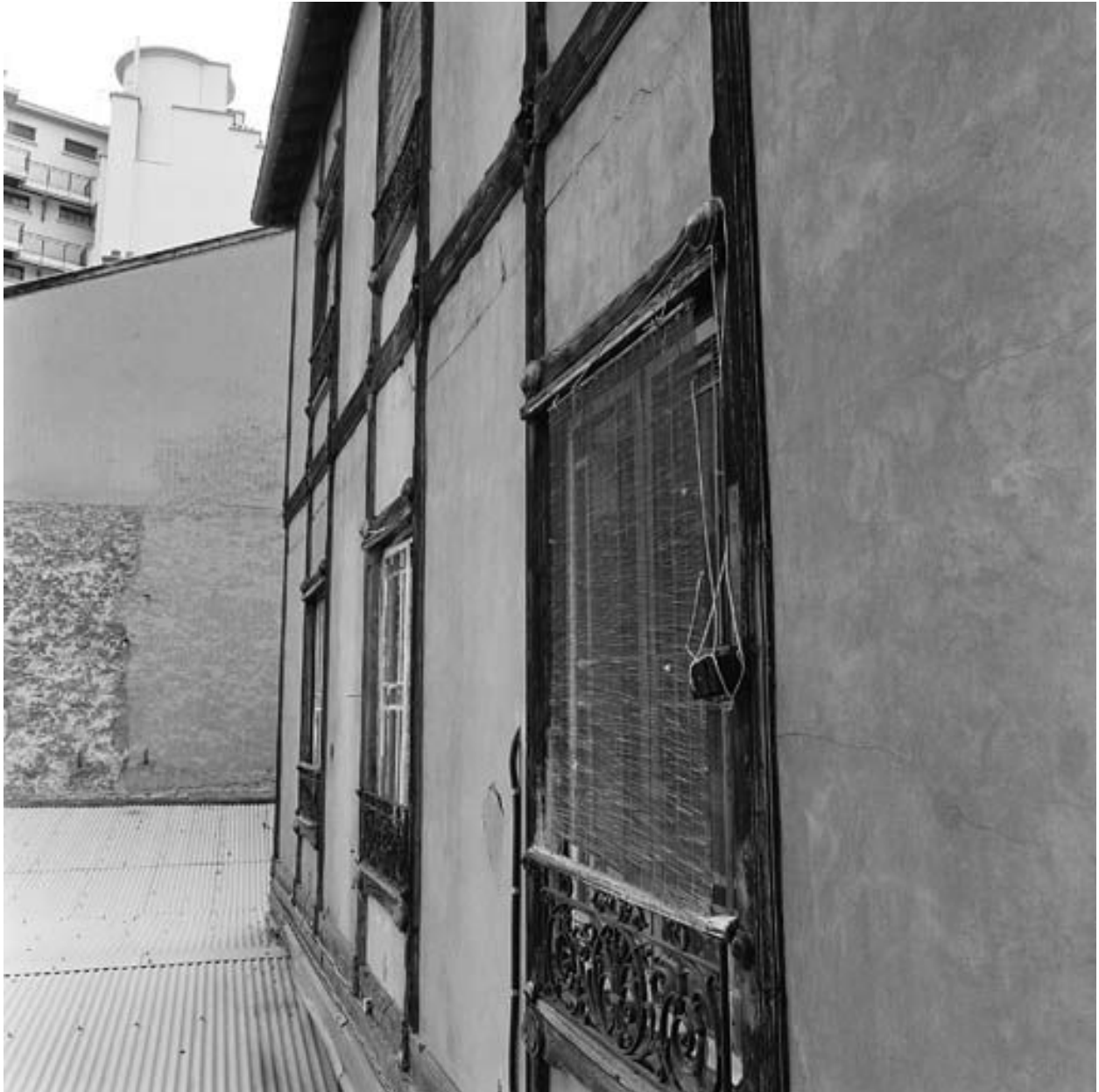
L'élévation postérieure vue depuis le premier étage
