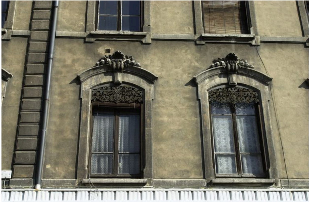
Fenêtres médianes du premier étage carré
