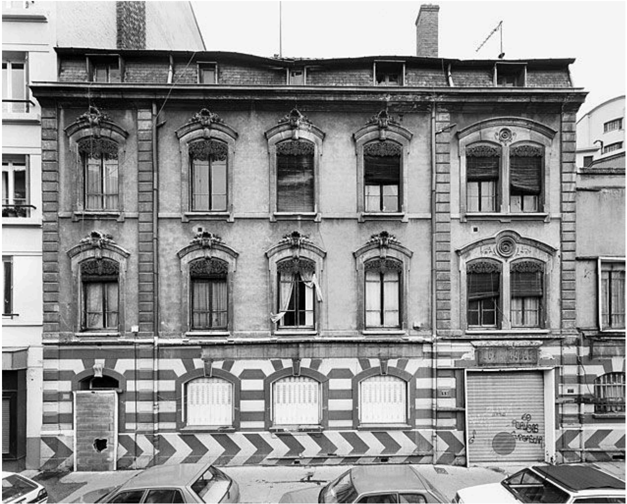
L'élévation antérieure après enlèvement du bardage métallique
