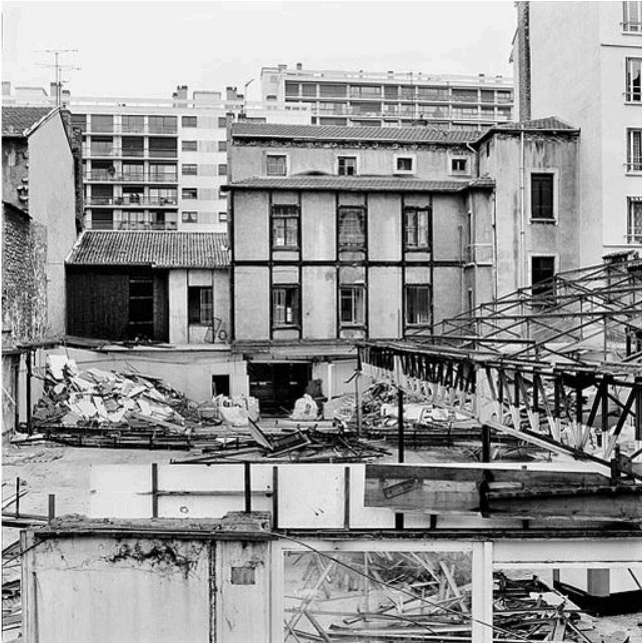
L'élévation postérieure après démolition de l'entrepôt donnant sur la rue Turbil
