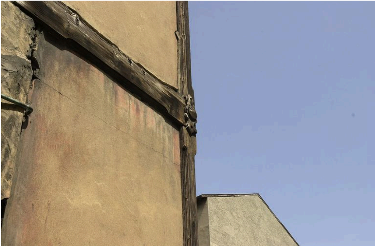
Elévation postérieure : détail
