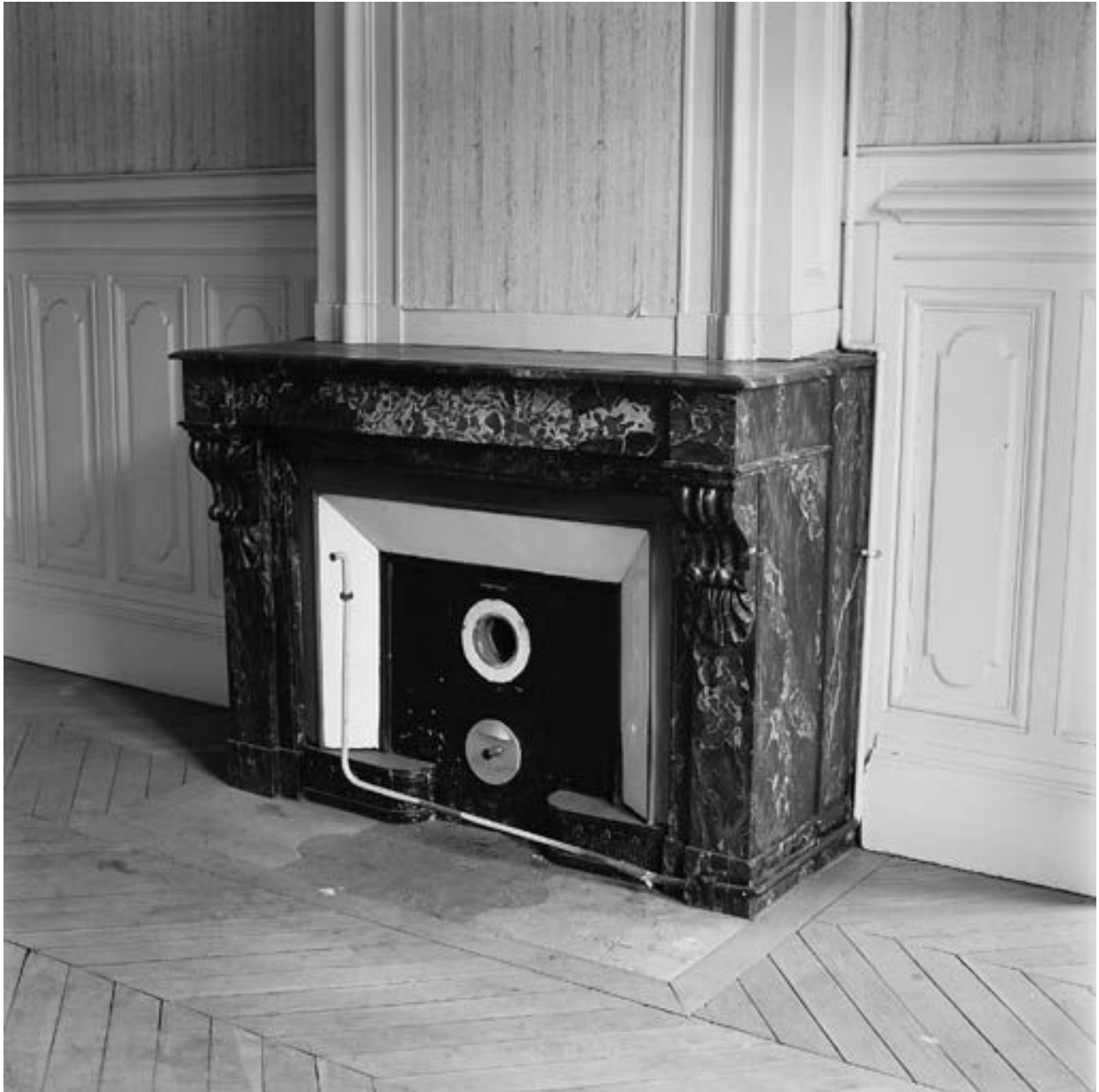
Deuxième étage : cheminée en marbre Portor
