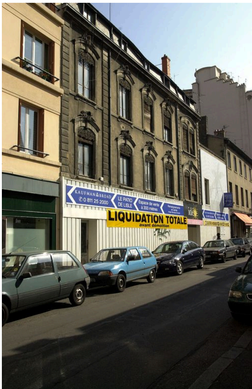
Vue générale de la maison sise au 153 rue Baraban
