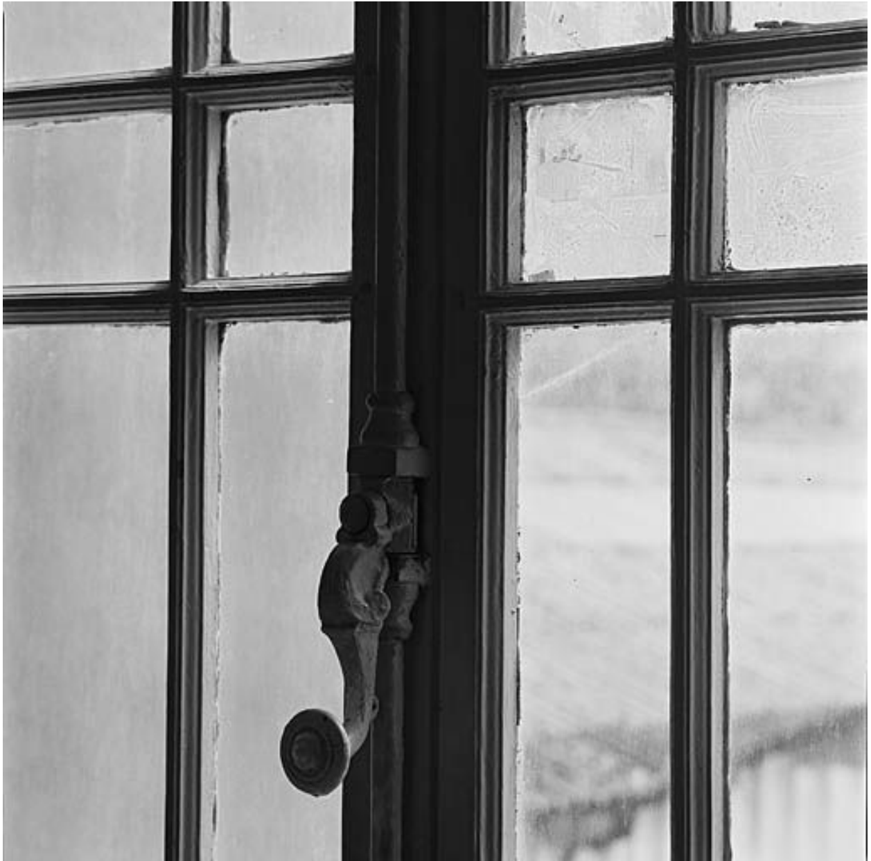
Poignée de fenêtre, élévation postérieure
