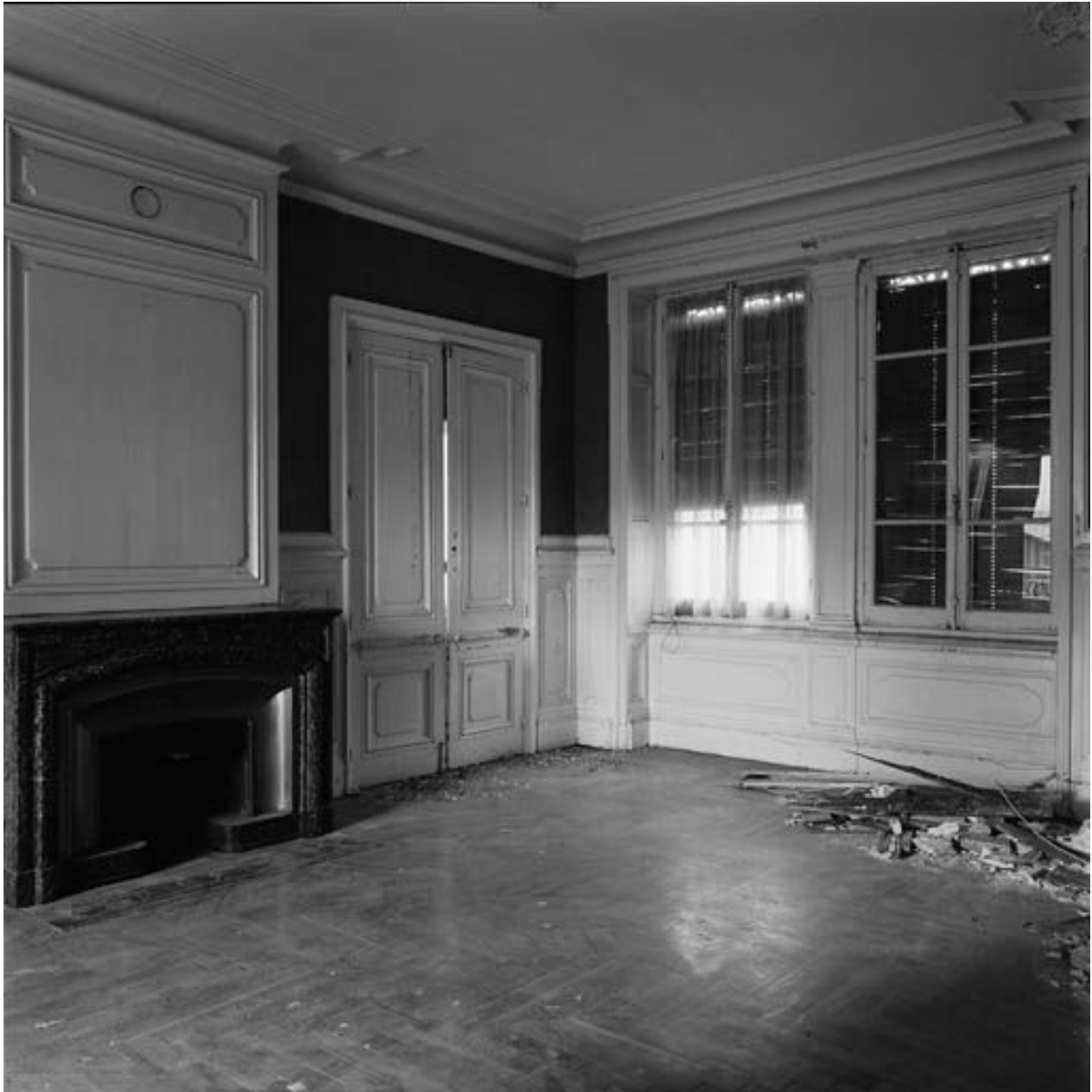
Premier étage : vue générale de la pièce de réception sud de l'appartement principal
