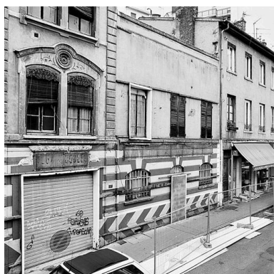
Elévation antérieure de la partie droite de la maison, après enlèvement du bardage métallique Phot. Didier Gourbin IVR82_20036903280X
