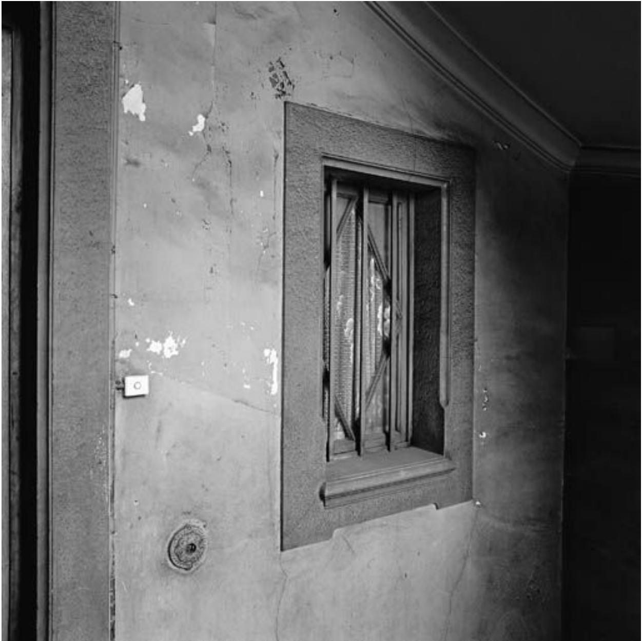
Cage d'escalier : fenêtre de second jour éclairant un appartement
