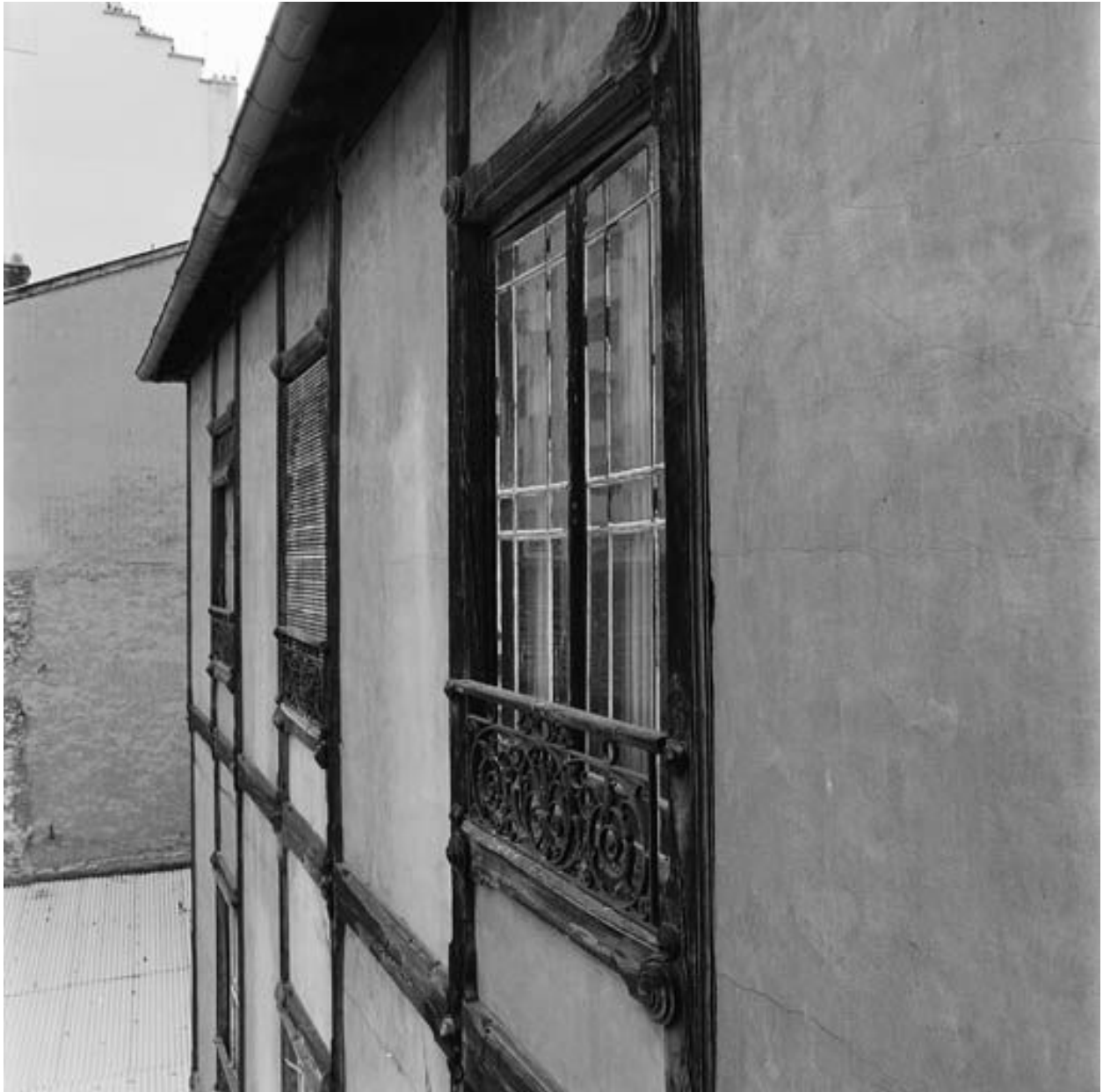
Vue partielle de l'élévation postérieure (2e étage)
