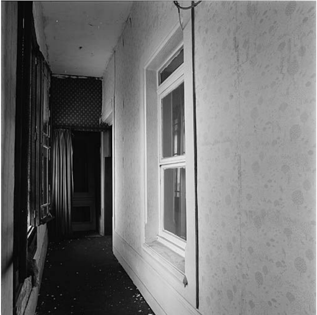
Fenêtre donnant sur la galerie (élévation postérieure)
