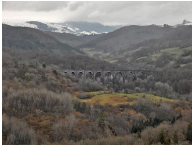
Le viaduc courbe de Barajol vu depuis le nord, côté concave. Phot. Christian Parisey IVR84_20191500189NUCA
