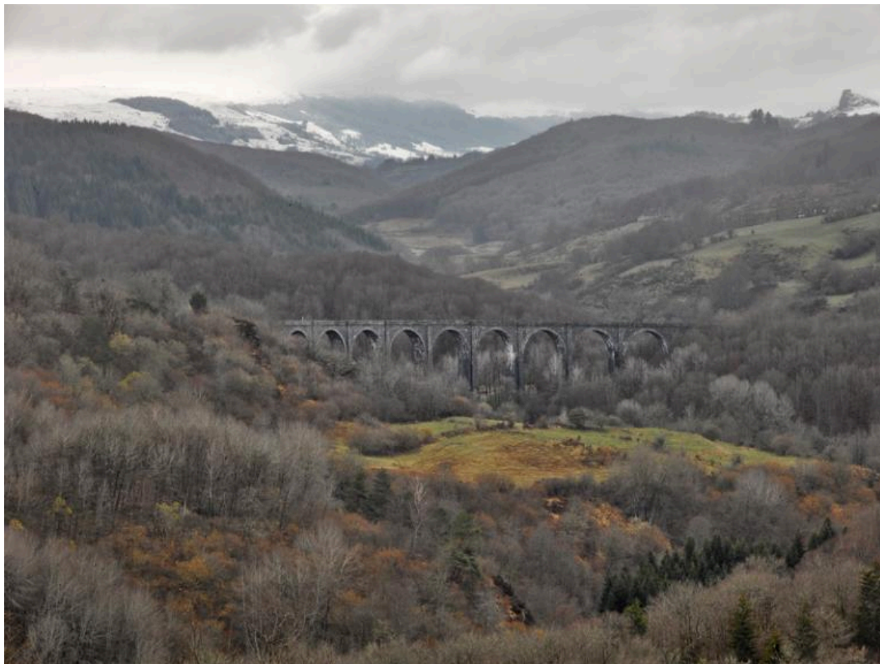
Le viaduc courbe de Barajol vu depuis le nord, côté concave.
