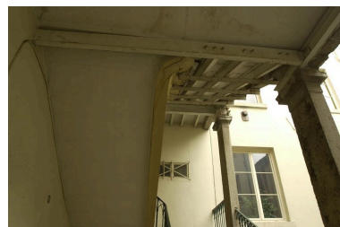
Etalement d'une volée de l'escalier, côté est Phot. Véronique Belle IVR82_20076901174NUCA
