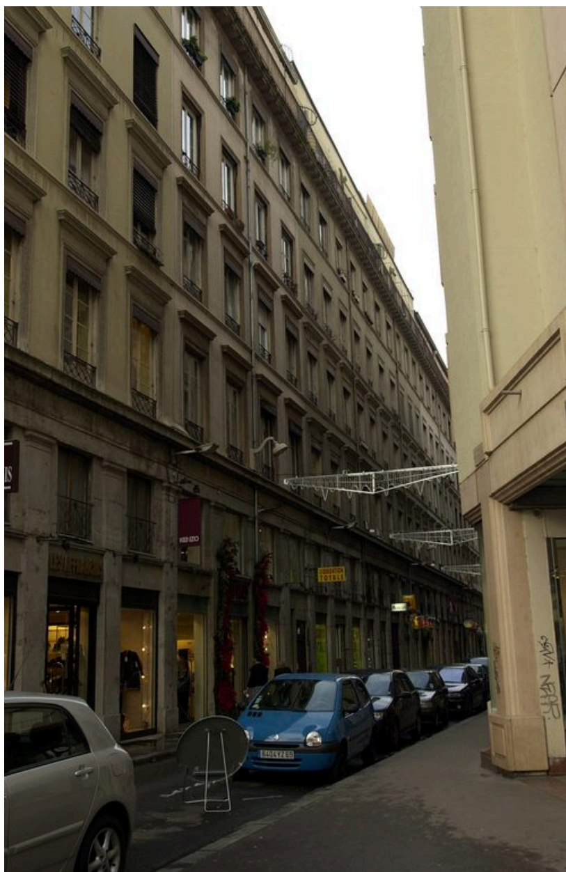
Vue générale depuis la rue Mercière
