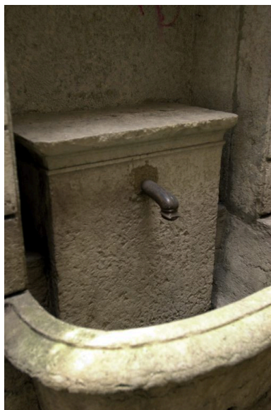
La fontaine monumentale : détail Phot. Véronique Belle IVR82_20076901179NUCA
