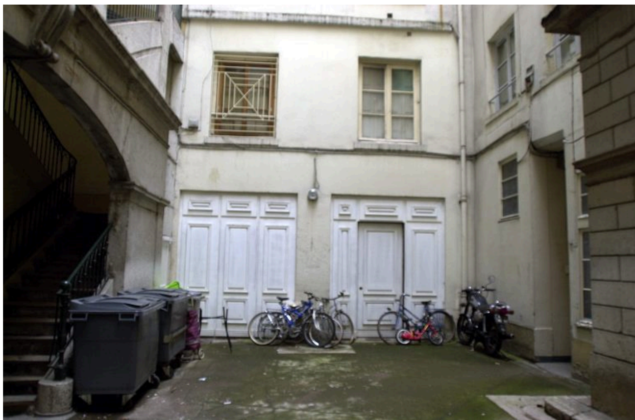
Elévation est de la cour
