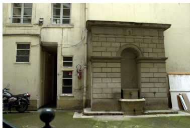
Elévation sud de la cour avec la fontaine monumentale Phot. Véronique Belle IVR82_20076901176NUCA
