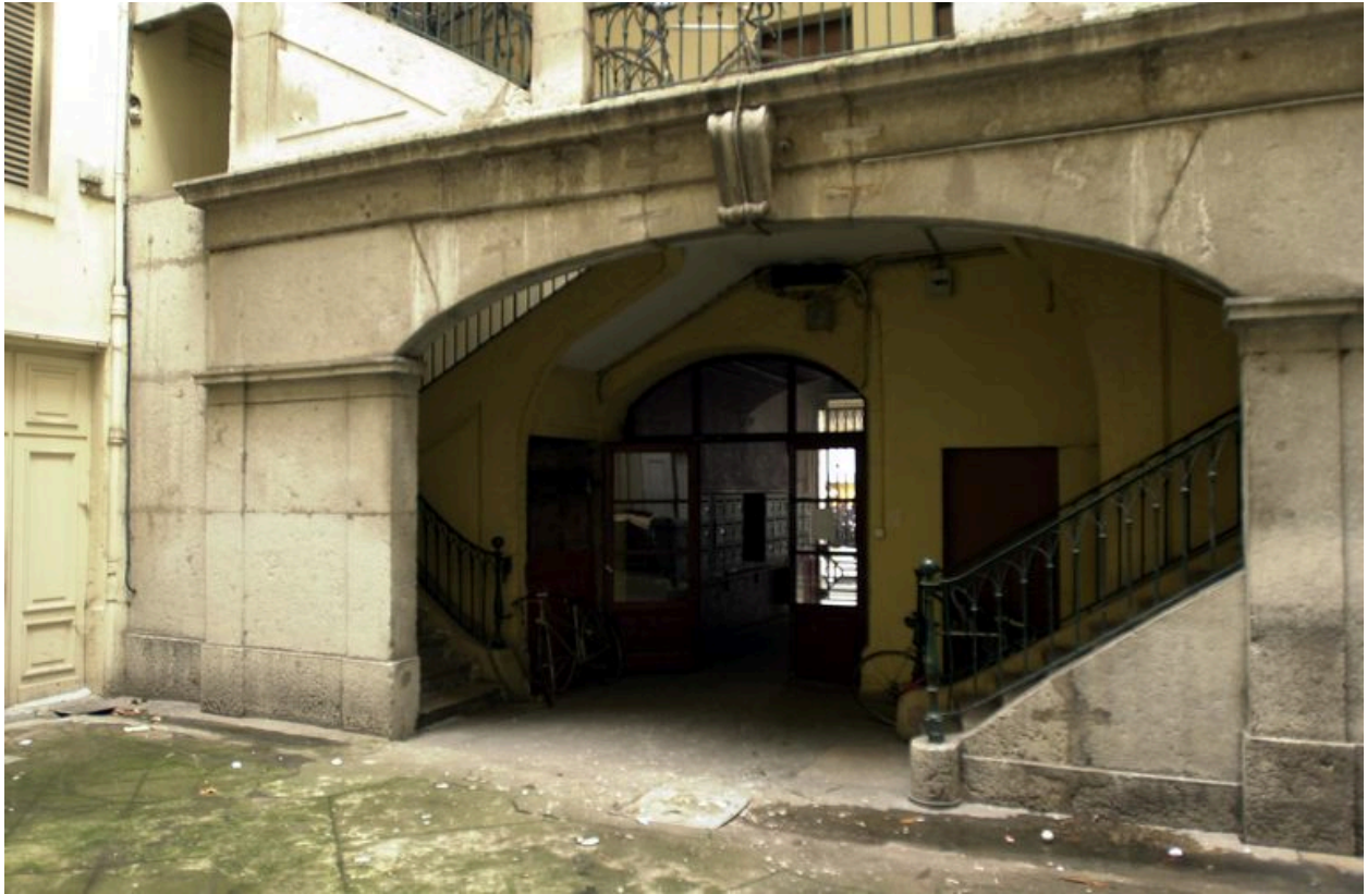
Porche et rez-de-chaussée de la cage d'escalier
