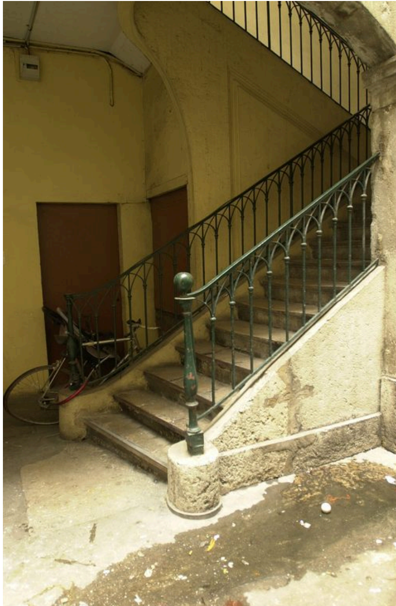
Cage d'escalier : départ de la volée est
