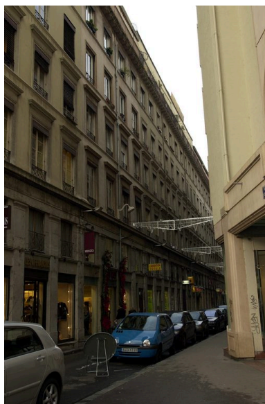
Vue générale depuis la rue Mercière Phot. Véronique Belle IVR82_20076901169NUCA
