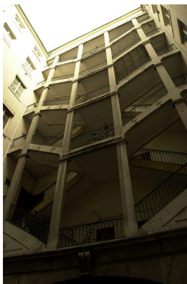
La cage d'escalier Phot. Véronique Belle IVR82_20076901170NUCA
