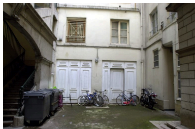
Elévation est de la cour Phot. Véronique Belle IVR82_20076901177NUCA
