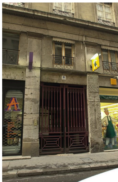
Détail de la porte cochère Phot. Véronique Belle IVR82_20076901167NUCA
