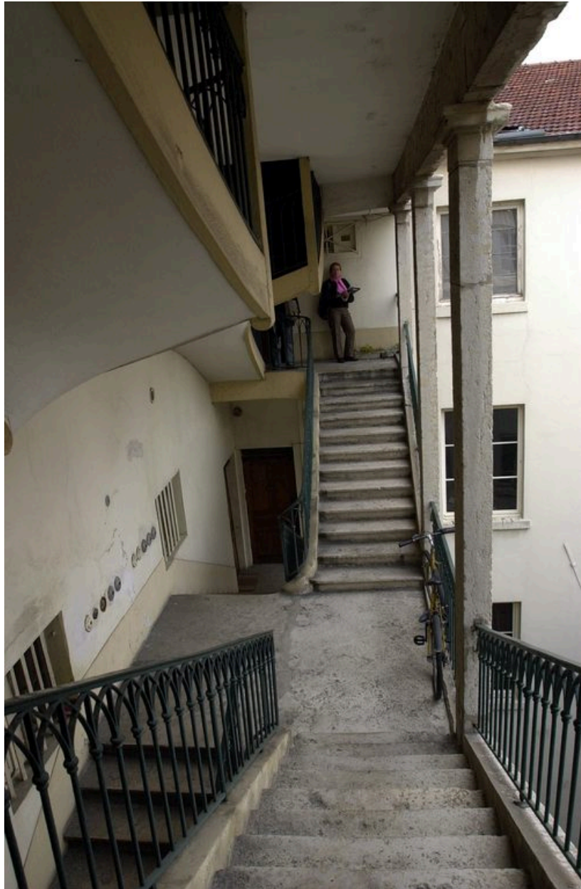
Volées d'escalier et repos depuis un palier
