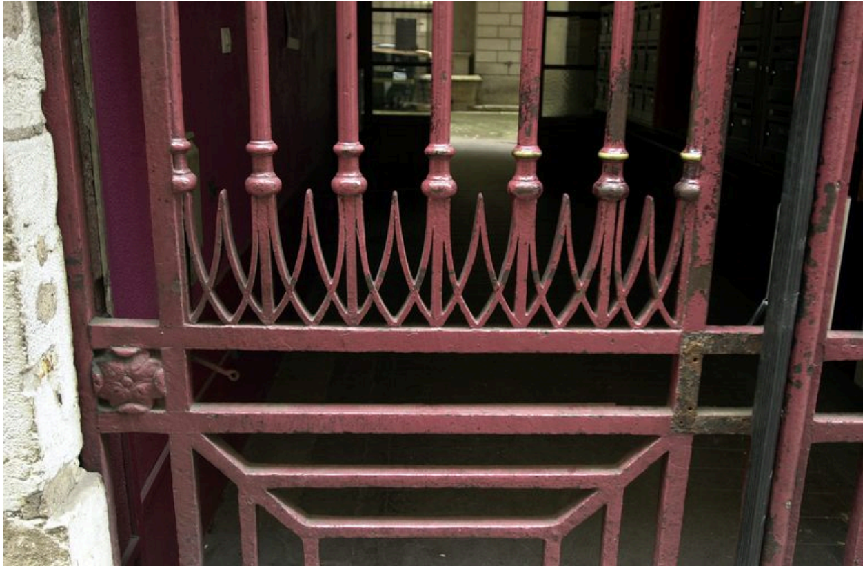
Porte cochère : détail de la grille
