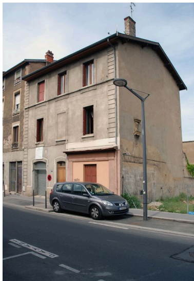
Élévation antérieure, vue depuis le Nord-Ouest Phot. Catherine Guégan IVR82_20096900757NUCA
