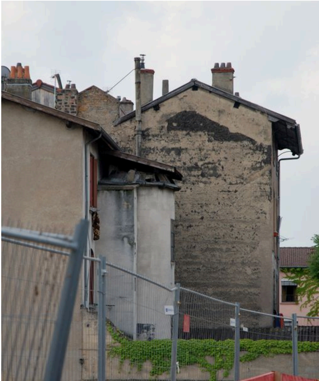
Elévation latérale et postérieure, détail sur la tourelle de la cage d'escalier.
