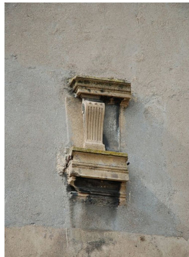
Détail de la façade latérale Ouest Phot. Catherine Guégan IVR82_20096900758NUCA
