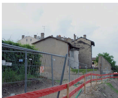
Élévation latérale et postérieure. Phot. Catherine Guégan IVR82_20096900759NUCA
