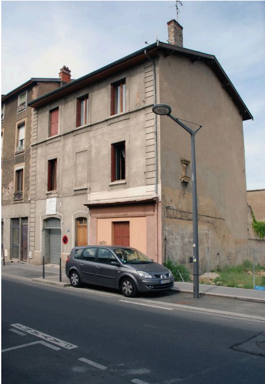
Elévation antérieure, vue depuis le Nord-Ouest
