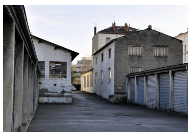
Vue ouest des ateliers Phot. Nadine Halitim-Dubois IVR82_20116900341NUCA
