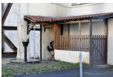
Détail abris Phot. Nadine Halitim-Dubois IVR82_20116900342NUCA
