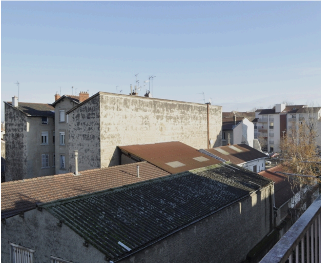
Vue sud-est du site
