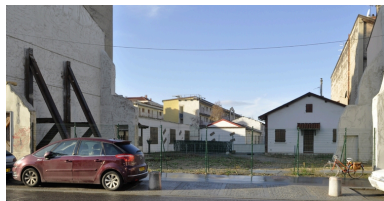
Vue est des ateliers Phot. Nadine Halitim-Dubois IVR82_20116900335NUCA
