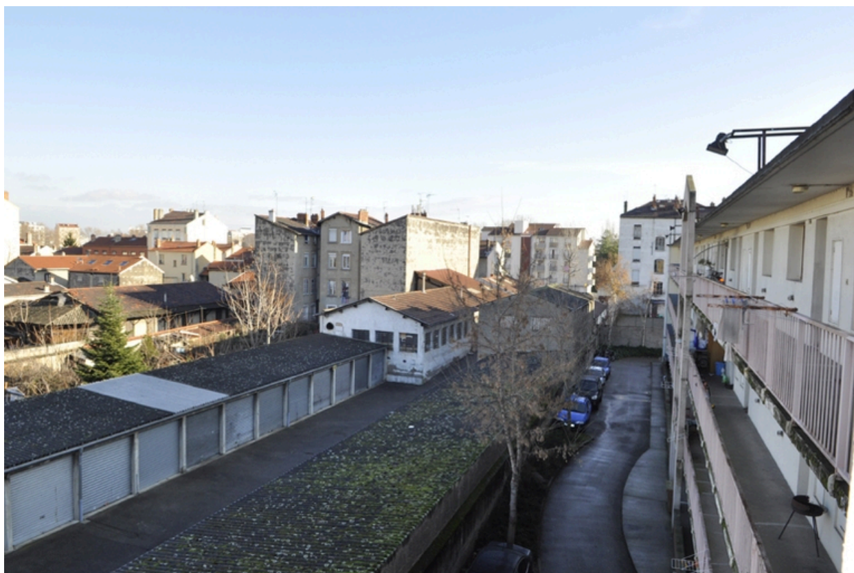
Vue d'ensemble ouest du site
