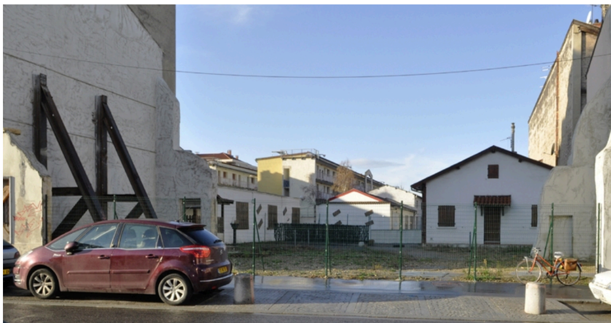
Vue est des ateliers
