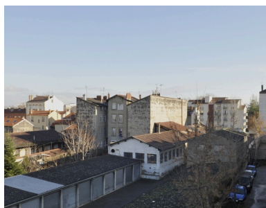
Vue ouest des ateliers Phot. Nadine Halitim-Dubois IVR82_20116900338NUCA
