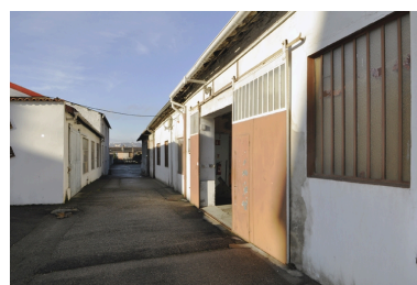
Détail portail coulissant Phot. Nadine Halitim-Dubois IVR82_20116900343NUCA
