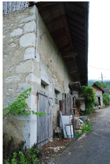
Vue de la façade en enfilade depuis l'ouest. Phot. Thierry Monnet IVR82_20157302581NUCA
