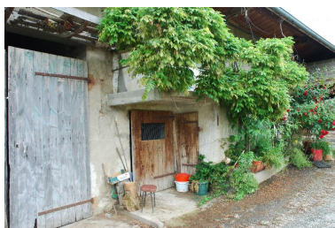
Vue partielle de l'entrée de l'étable sous une partie du logis. Phot. Thierry Monnet IVR82_20157302583NUCA
