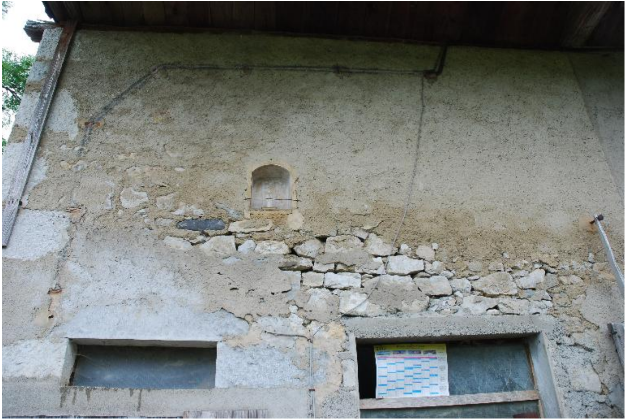
Détail de la niche située au-dessus des espaces situés à l'ouest de la ferme.
