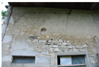
Détail de la niche située au-dessus des espaces situés à l'ouest de la ferme. Phot. Thierry Monnet IVR82_20157302582NUCA
