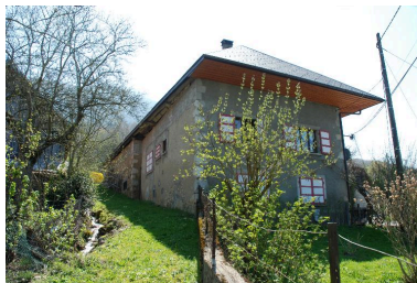
Vue arrière. Phot. Thierry Monnet IVR82_20147302208NUCA
