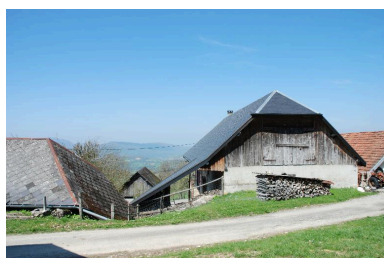
Vue de la partie aval : accès au fenil. Phot. Thierry Monnet IVR82_20147302209NUCA
