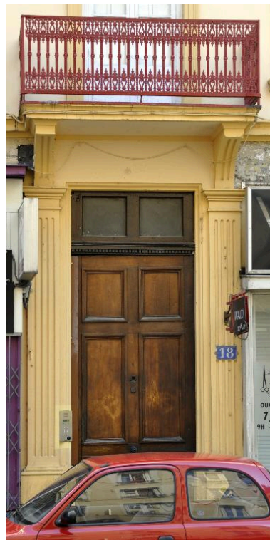
Porte piétonne surmontée d'un balcon central, piédroits cannelés Phot. Magali Delavenne IVR82_20156901237NUCA
