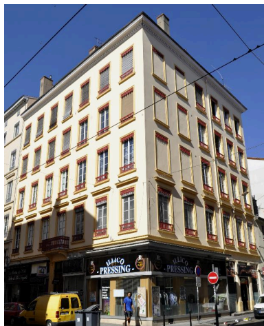
Vue d'ensemble Phot. Magali Delavenne IVR82_20156901235NUCA
