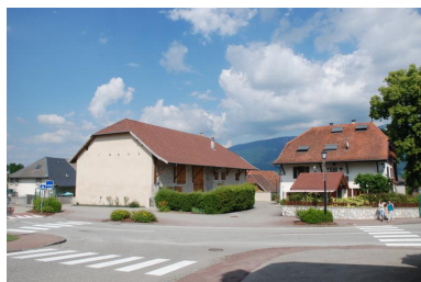
Vue depuis le sud-ouest. Phot. Thierry Monnet IVR84_20207400247NUCA
