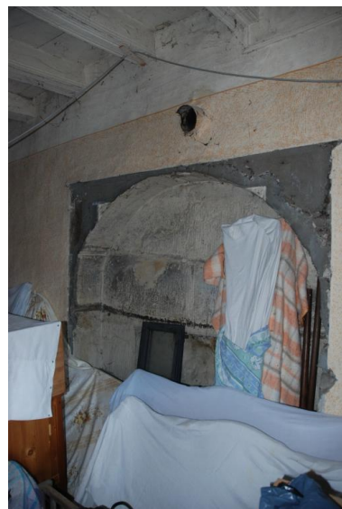
Vue intérieure de la première chambre : "bretagne". Phot. Thierry Monnet IVR84_20207400201NUCA
