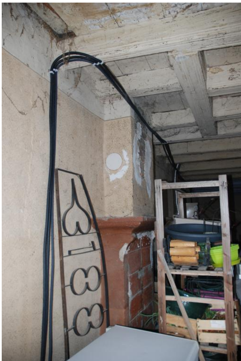
Vue intérieure de la cuisine : cheminée.
