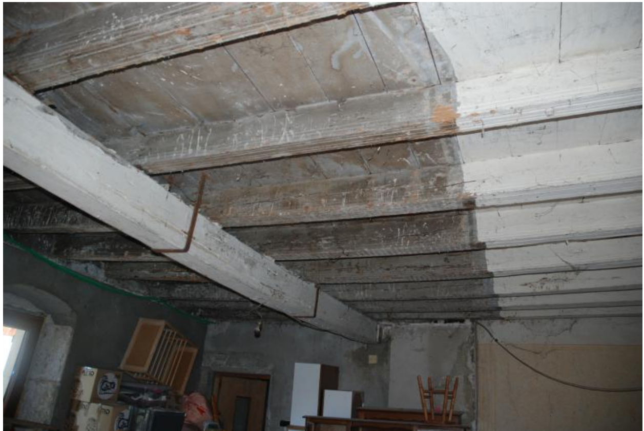
Vue intérieure : plafond de la cuisine.
