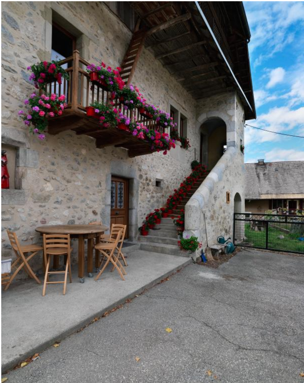
Vue de la façade est.
