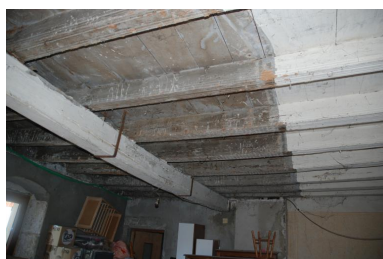
Vue intérieure : plafond de la cuisine. Phot. Thierry Monnet IVR84_20207400202NUCA
