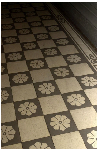
Carrelage en ciment moulé du vestibule Phot. V. Baud IVR82_20046904725NUCA
