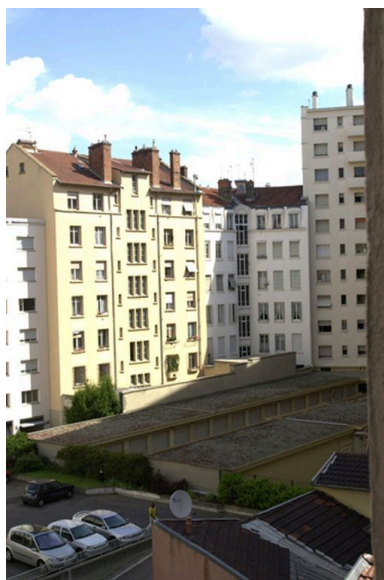
Elévation postérieure Phot. David Chevallier IVR82_20046904721NUCA
