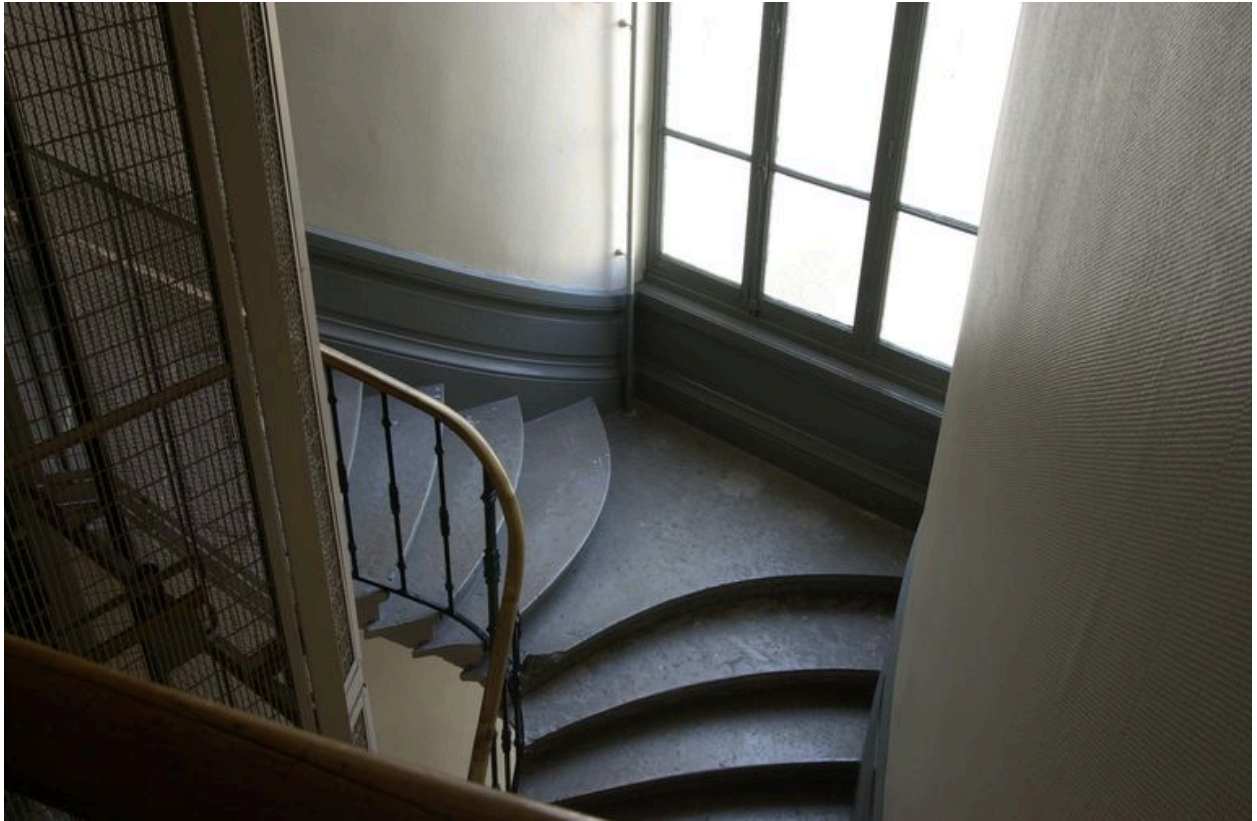
Détail d'un repos de l'escalier
