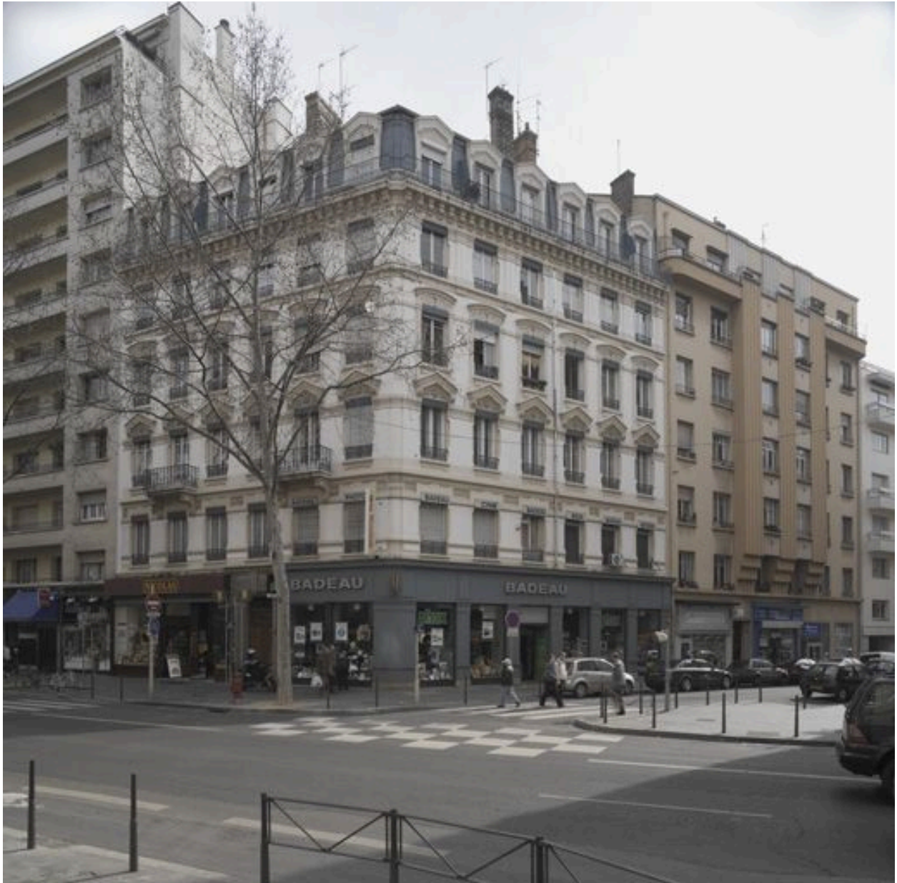
Vue générale de l'angle du cours Gambetta et de la rue Louis-Dansard
