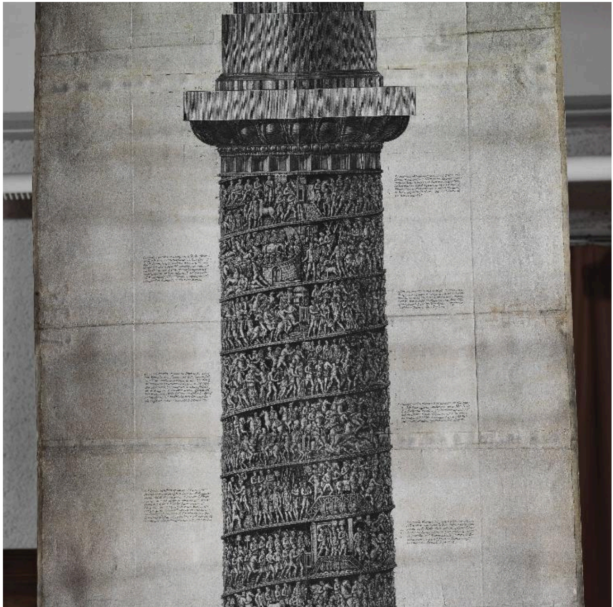
Fût, partie supérieure
