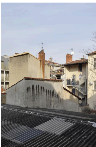
Vue d'ensemble des élévations postérieures : immeuble
