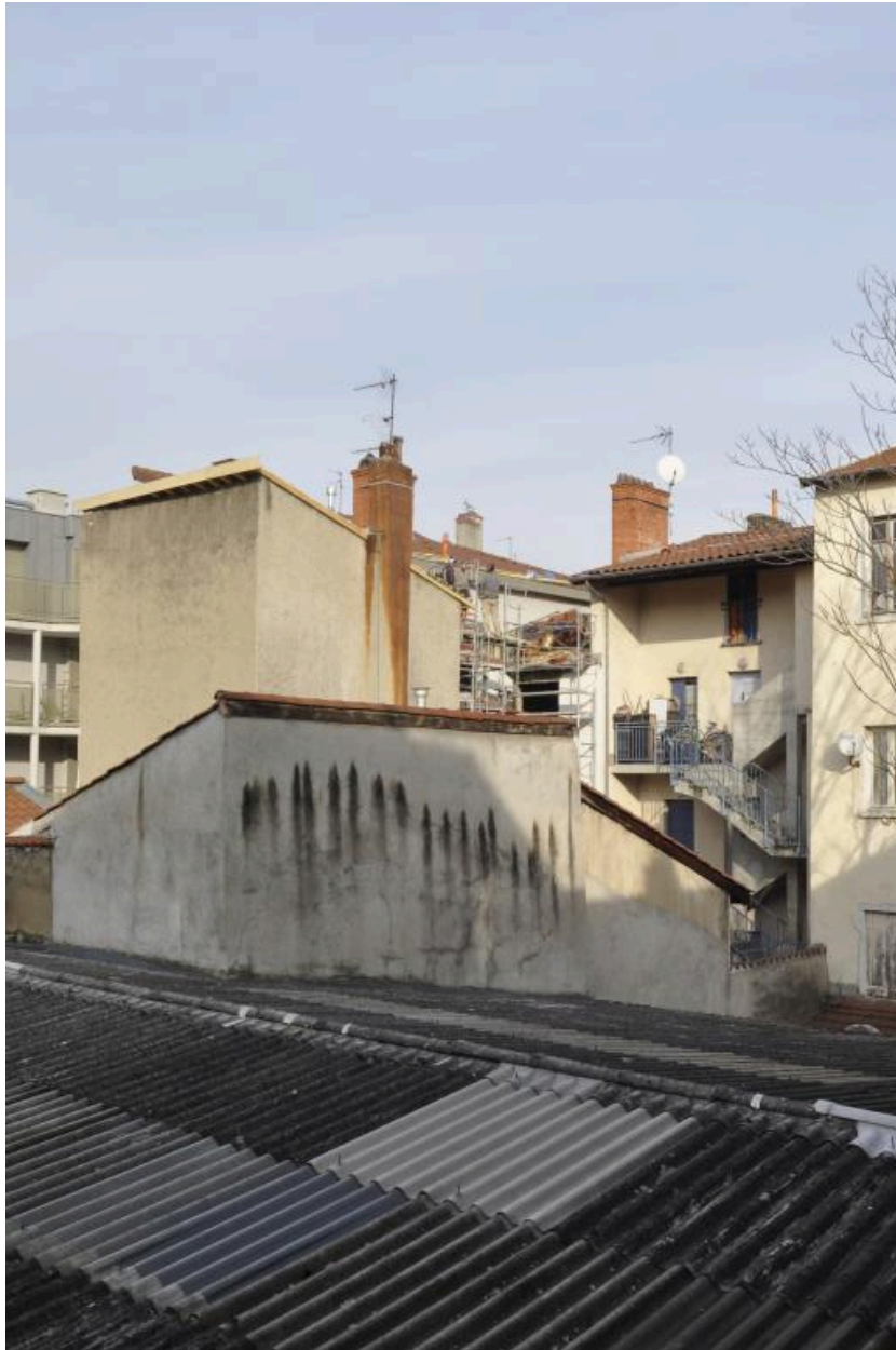
Vue d'ensemble des élévations postérieures : immeuble sur cour au premier plan, immeuble sur rue à l'arrière-plan
