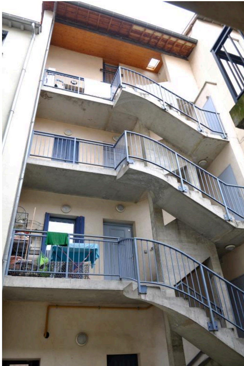
Immeuble sur rue, escalier moderne adossé à la façade postérieure
