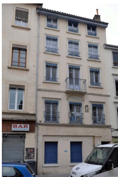
Immeuble sur rue, vue générale Phot. Magali Delavenne IVR84_20186900897NUCA
