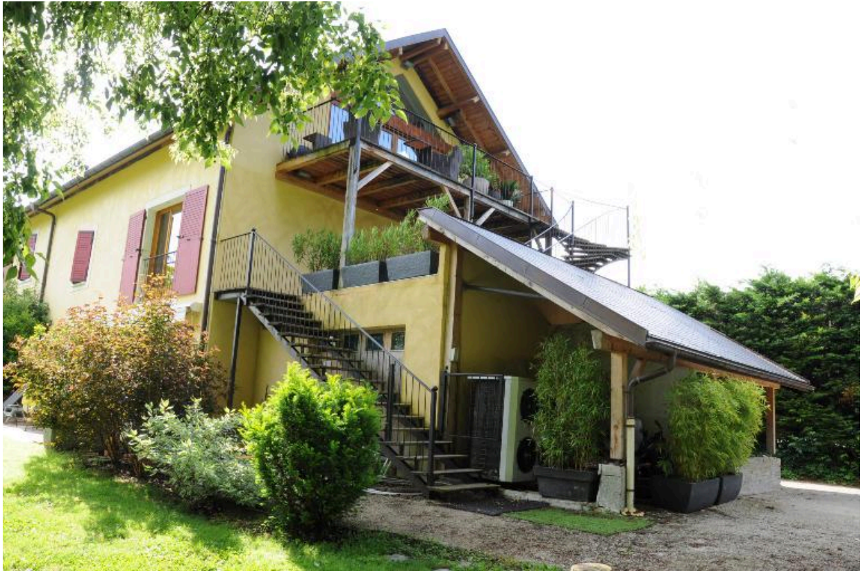
Détail du pignon ouest
