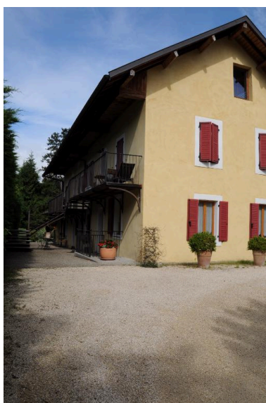
Pignon est et façade sud Phot. Denys Harreau IVR82_20147300847NUCA
