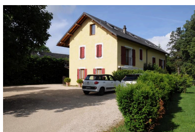
Vue d'ensemble Phot. Denys Harreau IVR82_20147300841NUCA
