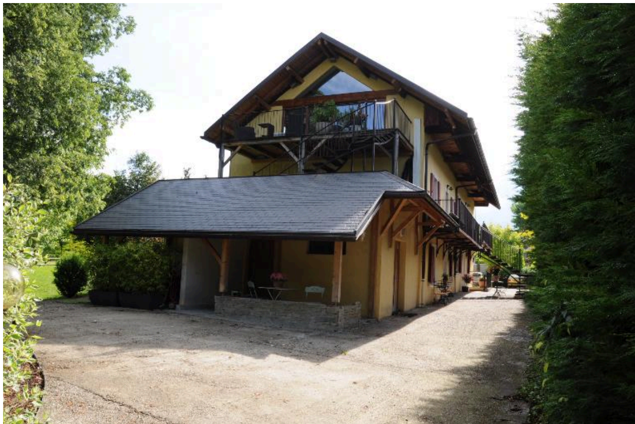
Pignon ouest et façade sud
