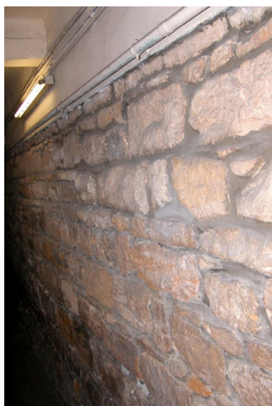
Mur en pierres apparentes du couloir Phot. N. Giroud IVR82_20046904082NUCA
