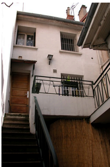
Elévation sur cour Phot. Maryannick Chalabi IVR82_20046904083NUCA
