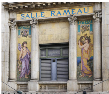
Vue d'ensemble Phot. Franck Trabouillet IVR84_20186900688NUCA
