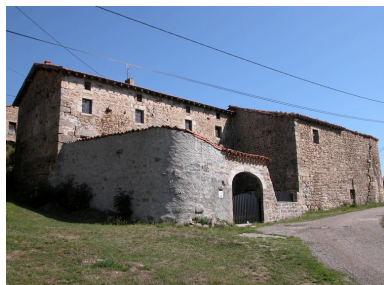
Vue générale. Phot. Thierry Monnet IVR82_20124201120NUCA
