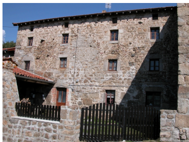
Vue d'ensemble du logis. Phot. Thierry Monnet IVR82_20124201119NUCA
